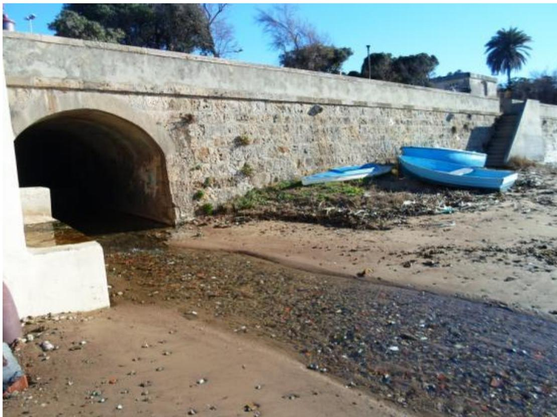
Sopra e sotto: sbocco del Rio Felciaio al centro della spiaggia con dettaglio (sotto) del condotto tombato
