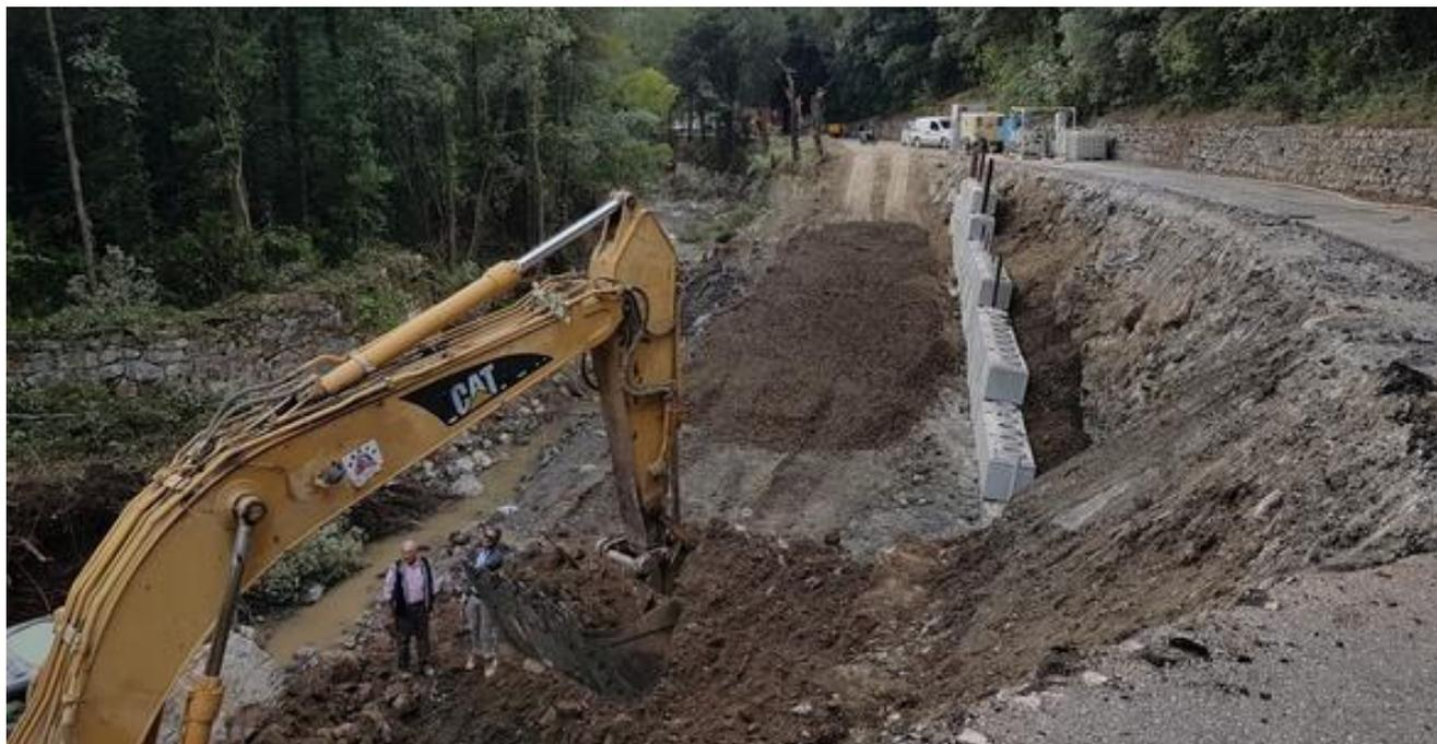
Sopra e sotto: fasi avanzate successive di ripristino e consolidamento del fenomeno gravitativo e della sede stradale, con palificazioni profonde e muri a retta di contenimento.
