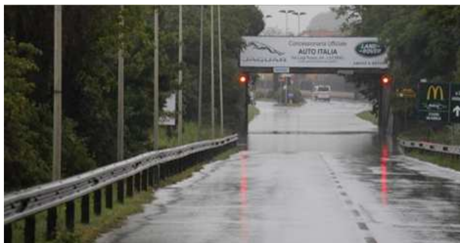
Figura 159 Allagamenti al sottopasso di Via Firenze
