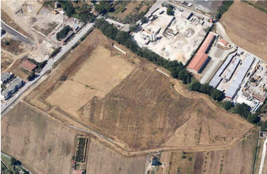
Figura 12 Cassa di espansione del Rio Cigna in fase di realizzazione
