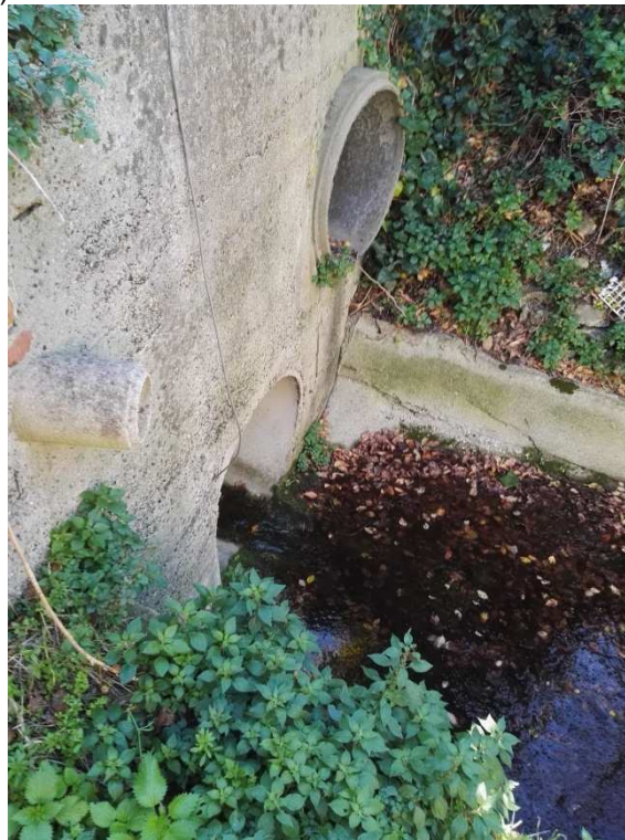
Figura 119 Tombamento a valle della Ferrovia
