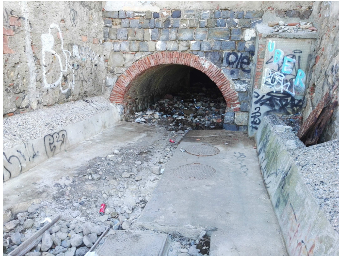
Figura 118 Sblocco a mare del Botro delle Pianacce
