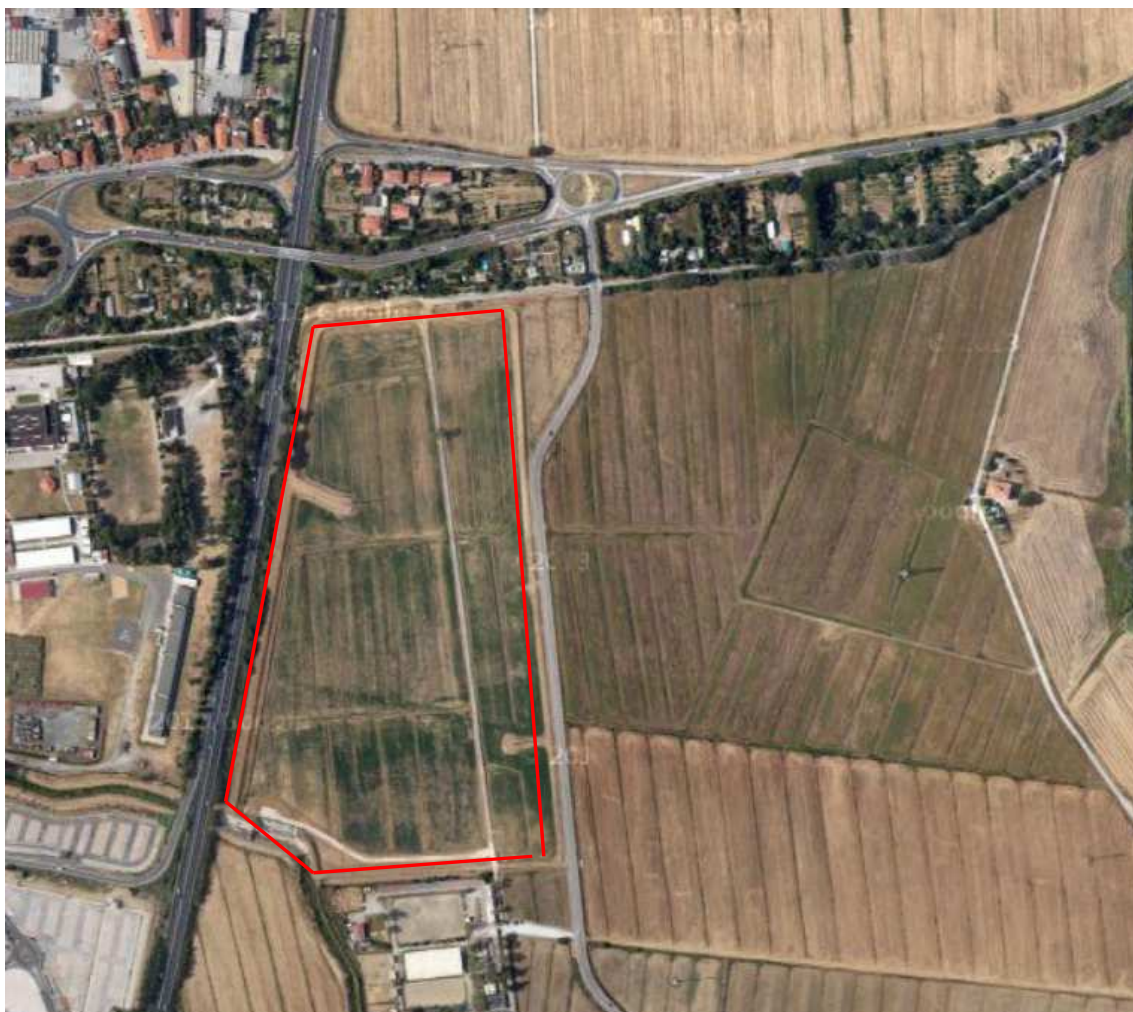
Figura 4 Cassa di espansione sul rio Cignolo
