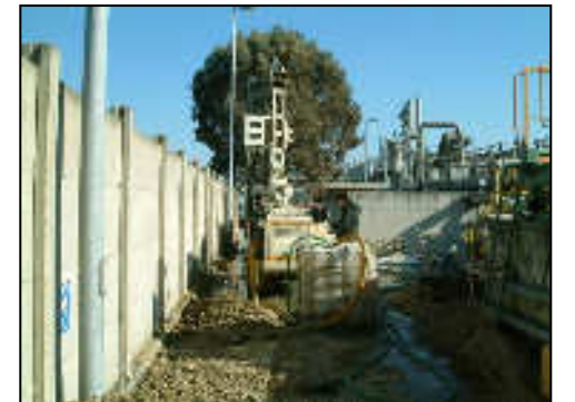
Inizio fase di carotaggio
