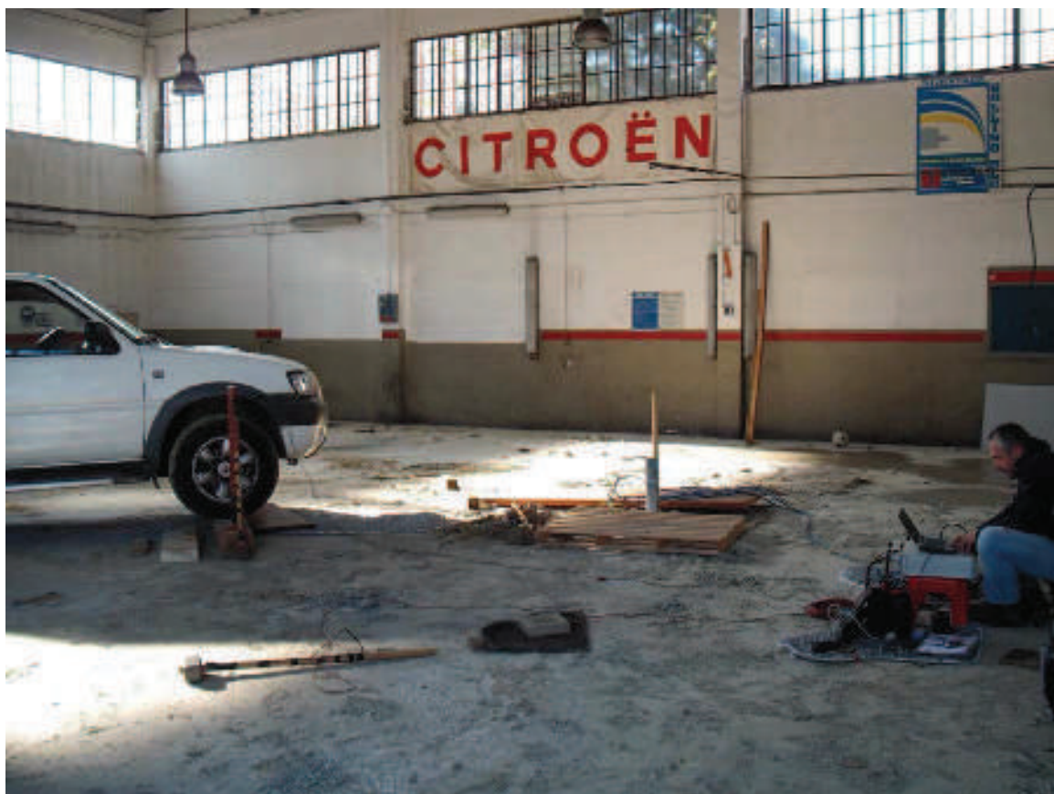
Indagine Down Hole –Documentazione fotografica.
