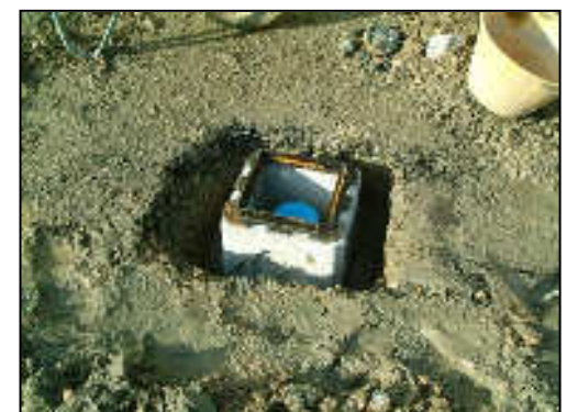
Realizzazione pozzetto piezometro
