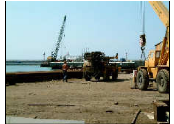
Fasi di piazzamento della sonda perforatrice
