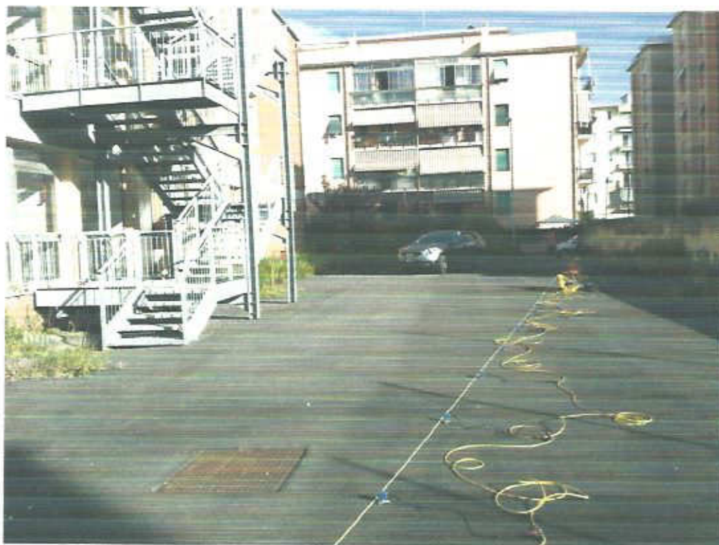
Prospezione M.A.S.W.: stendimento geofoni
