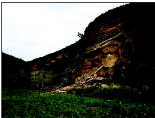
Foto 2 - Vista area estrattiva in destra idrografica
