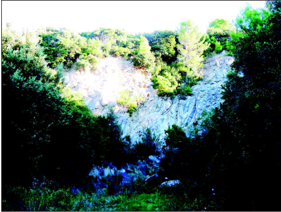
Foto 1 - Veduta in direzione N
