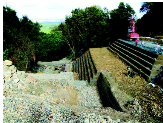
Foto 3- Opere di sostegno del versante (terre armate)
