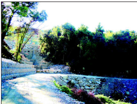
Foto 2- Opere di sostegno del versante (gabbionate)
