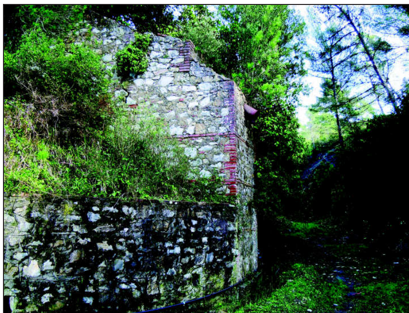
Foto 2 – Edificio a servizio ex-cava (vista W)
