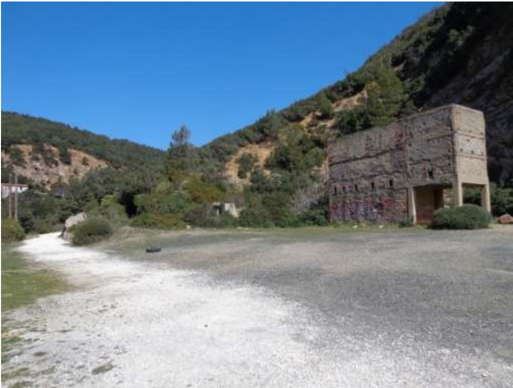
Foto 4 Cave di Calignaia: Ex Cava 1 piazzale di cava più prossimo alla linea di costa, già utilizzata per area parcheggio e a maggiore artificialità, ma con elementi vegetali e di naturalità da conservare.
