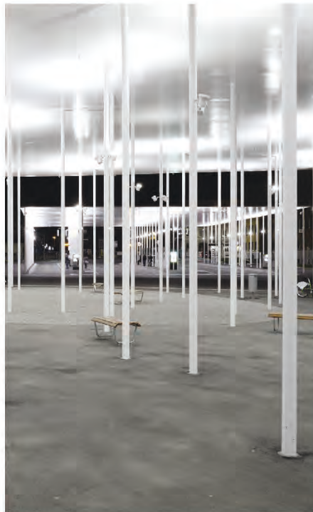
A partire dall'alto: pensiline e stazione ferroviaria; le due pensiline che, di notte, diventano lanterne nel panorama cittadino.
