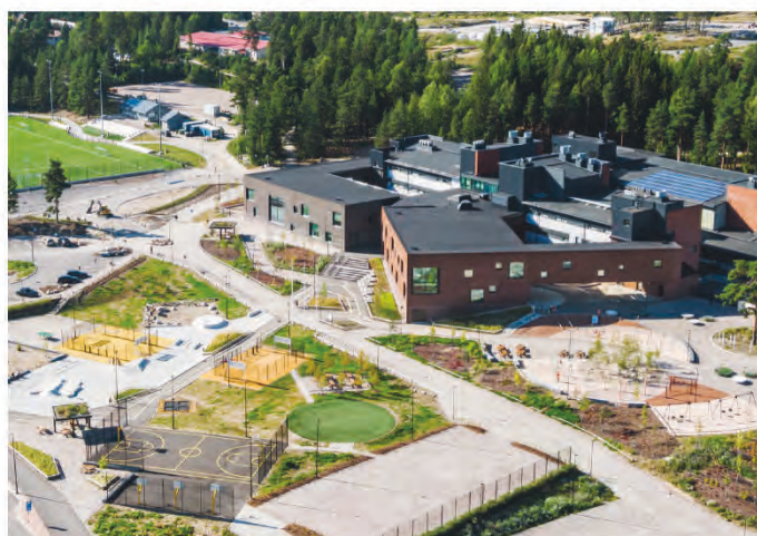
Gli spazi davanti alla scuola, con percorsi ciclopedonali e aiuole. Vista a volo d'uccello sull'intera area di intervento.
