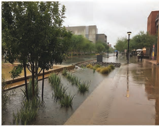
Le bioswale durante un giorno di pioggia; il rain garden nella corte centrale, con piante autoctone dell'Arizona; le trincee di ritenzione; il viale centrale del campus con le nuove piantagioni, allea ombreggiata da palme.
