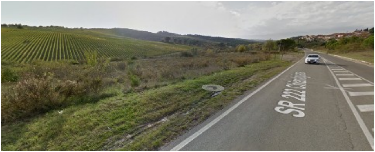
IC3.18, veduta obliqua dell'area di intervento ad ovest (fonte Google Street View)
