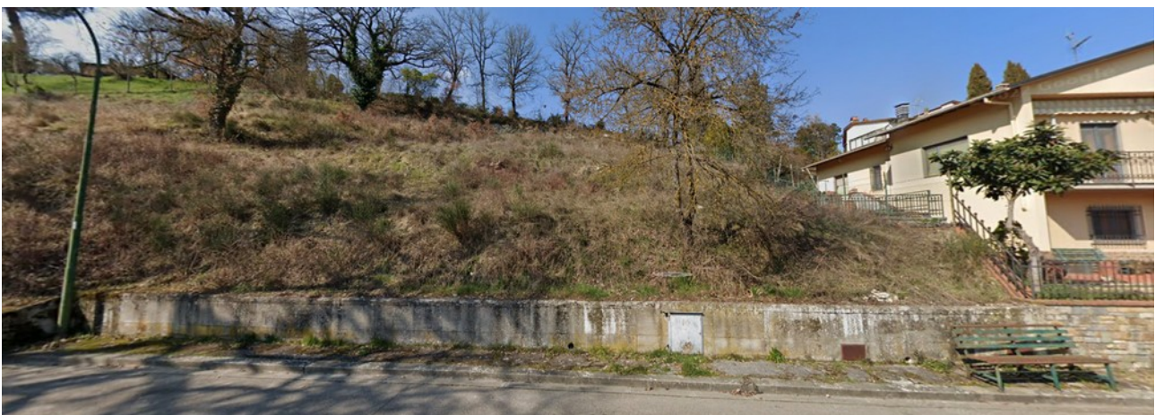
IC1.05, veduta obliqua dell'area di intervento da nord (fonte Google Street View)
