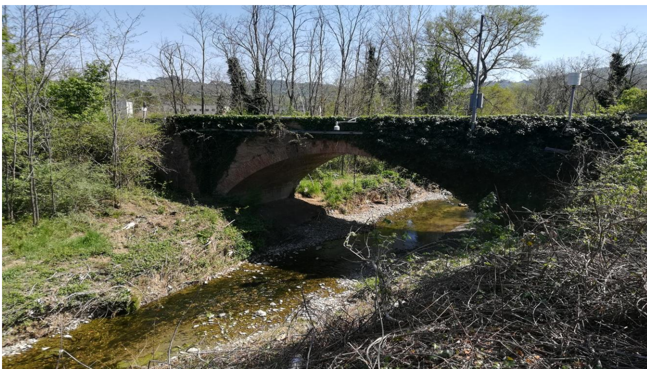
Figura 5.15 - Ponte della SP 119 del Palagione, nel punto in cui attraversa il Torrente Ema.
