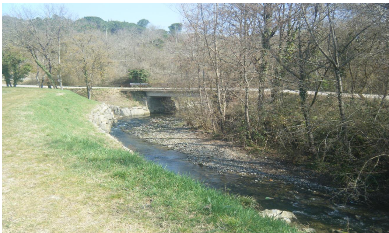
Figura 5.11 - Argine, in destra idraulica, a monte dell’area industriale di Meleto
