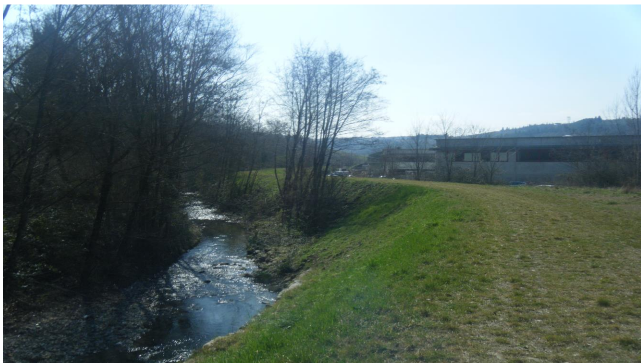
Figura 5.12 - Argine, in destra idraulica, a monte dell'area industriale di Meleto
