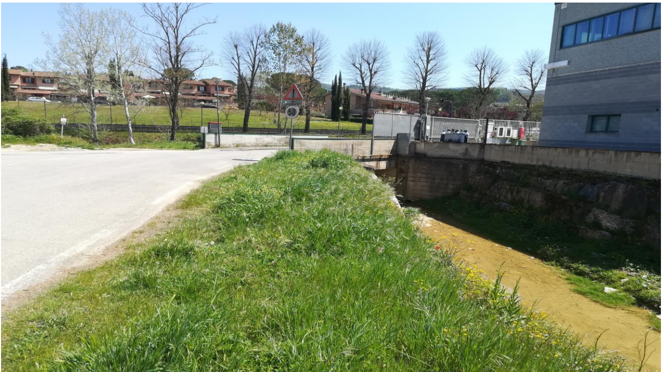
Figura 5.3 – Argini, in destra e sinistra idraulica, sul Borro della Paurosa a monte della confluenza con il Fiume Greve
