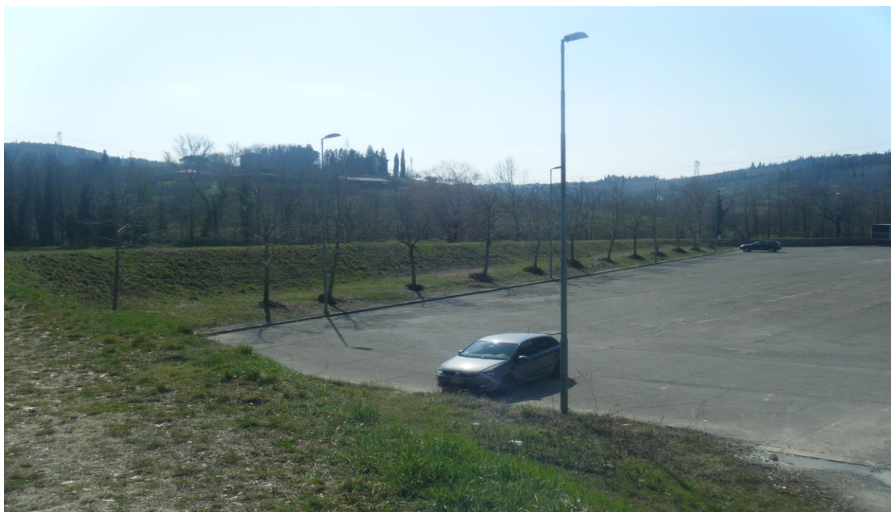
Figura 5.13 - Argine, in destra idraulica, nell'area industriale di Meleto
