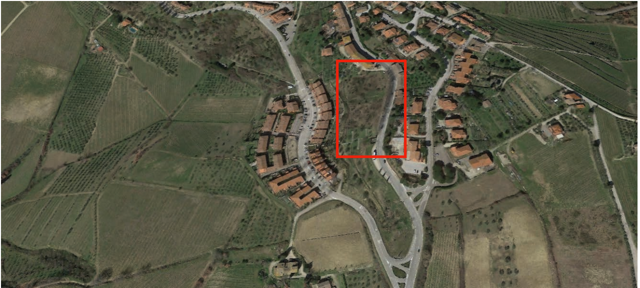
PA 7.1, veduta obliqua dell'area di intervento da sud (fonte Google Street View)
