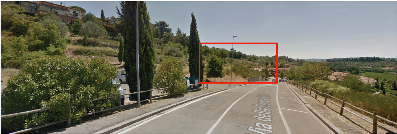
PA 7.1, veduta dell'area di intervento da via diella Conca d'Oro (fonte Google Street View)
