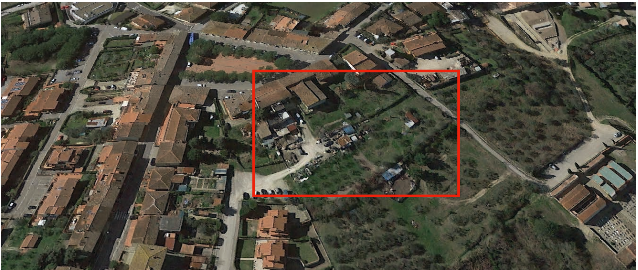
PA 3.4, veduta obliqua dell'area di intervento da sud (fonte Google Street View)
