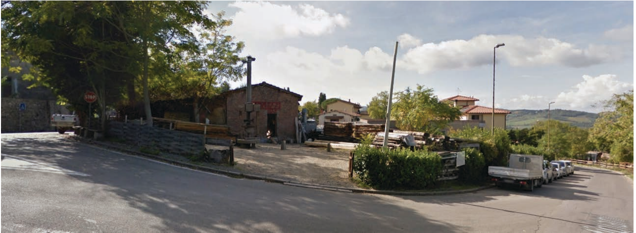
IC 7.2, veduta dell'area di intervento all'inizio di via degli Artigiani (fonte Google Street View)
