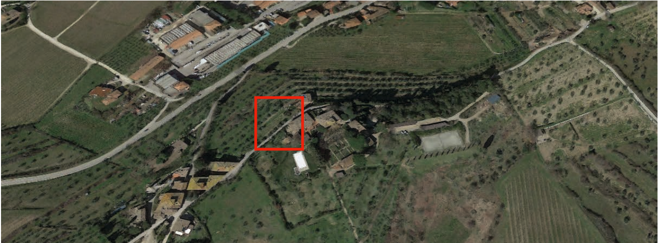
IC 7.1, veduta obliqua dell'area di intervento da sud (fonte Google Street View)
