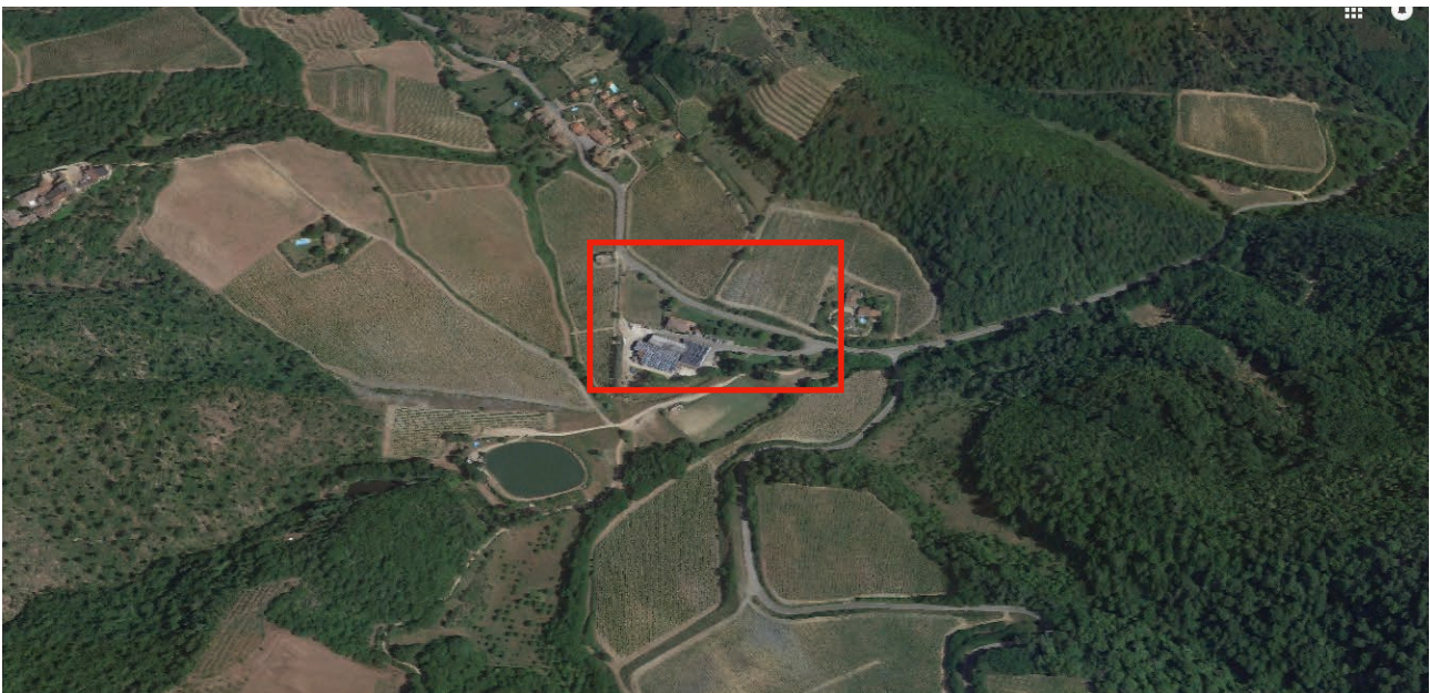
IC 6.1, veduta obliqua dell'area di intervento da sud (fonte Google Street View)
