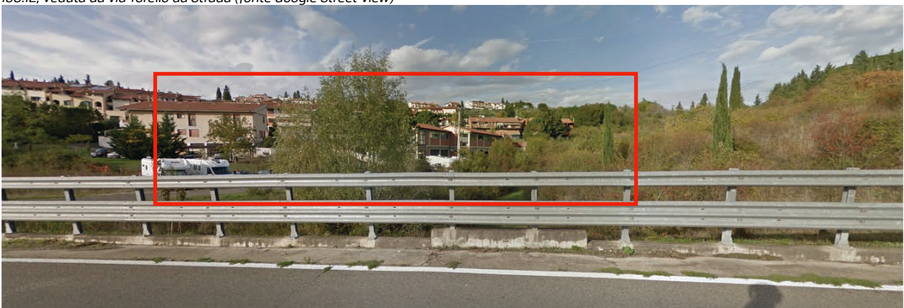
IC3.12, veduta da via Zenobi da Strada (fonte Google Street View)
