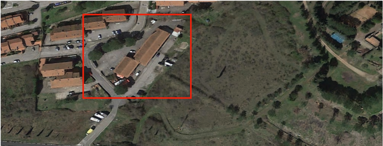
IC3.12, veduta obliqua dell'area di intervento (fonte Google Street View)
