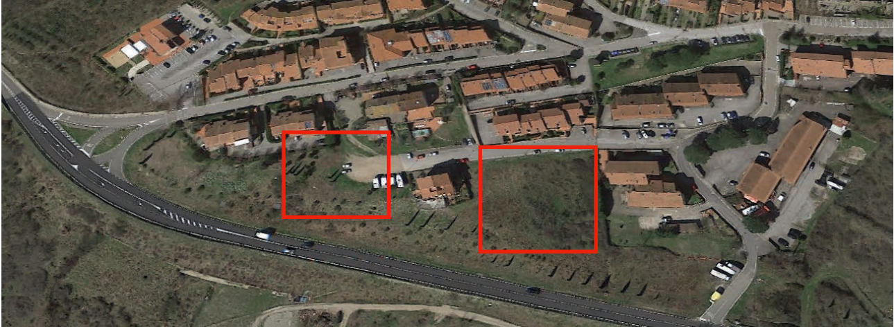
IC3.10, veduta obliqua dell'area di intervento (fonte Google Street View)
