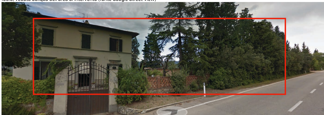
IC3.3, veduta da via Mario Rossi da nord (fonte Google Street View)
