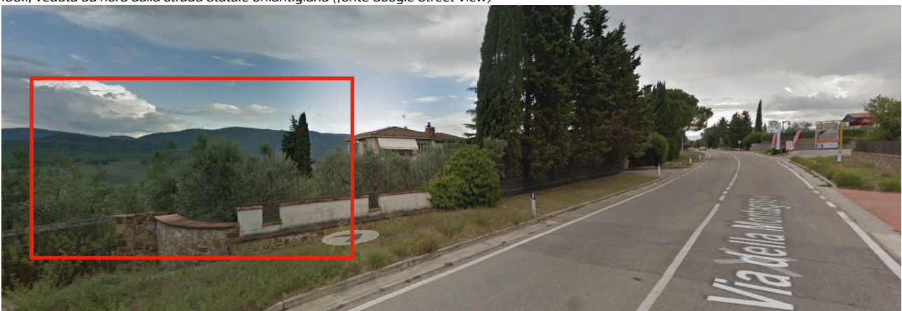
IC3.1, veduta diagonale da nord più ravvicinata (fonte Google Street View)
