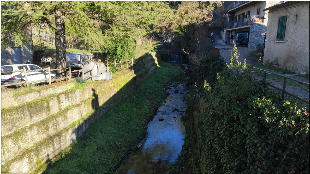
Figura 4. 1 – Briglia sul T. Massellone a monte dell'abitato di Gaiole
