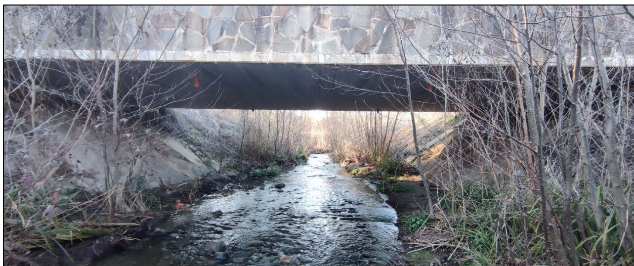
Figura 4. 17 – Terzo attraversamento sul Borro Grande
