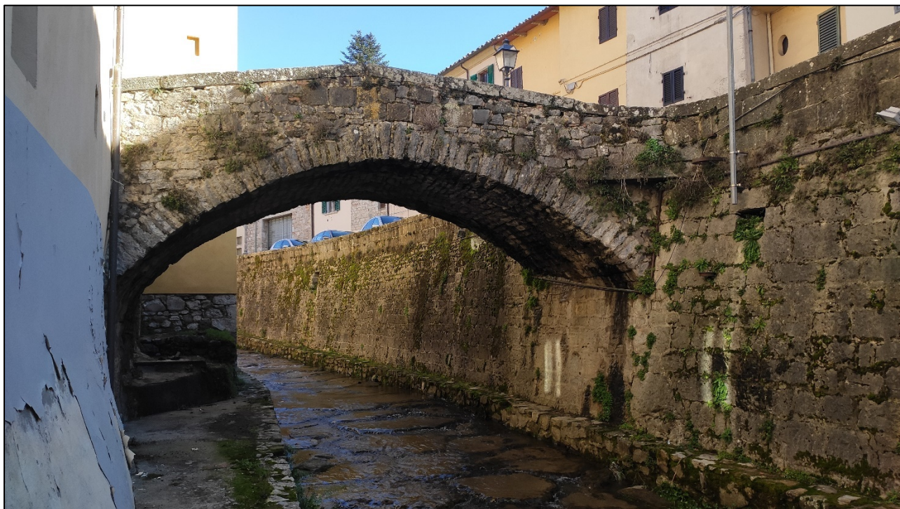
Figura 4. 5 – attraversamento pedonale sul T. Massellone
