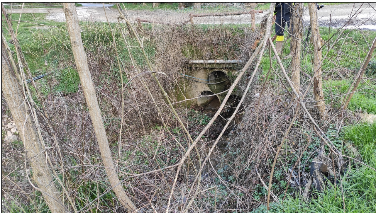
Figura 4. 13 – attraversamento carrabile sul fosso delle Corti
