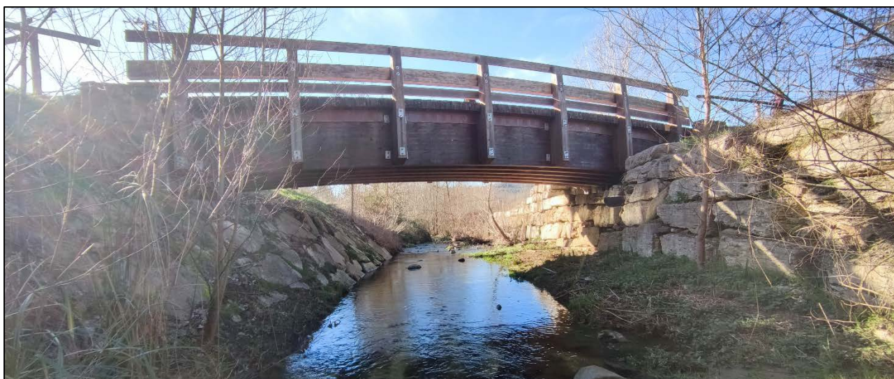
Figura 4. 16 – Secondo attraversamento sul Borro Grande
