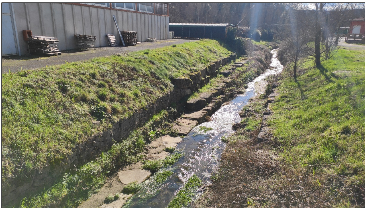
Figura 4. 10 – T. Massellone a monte della confluenza con il Borro Grande
