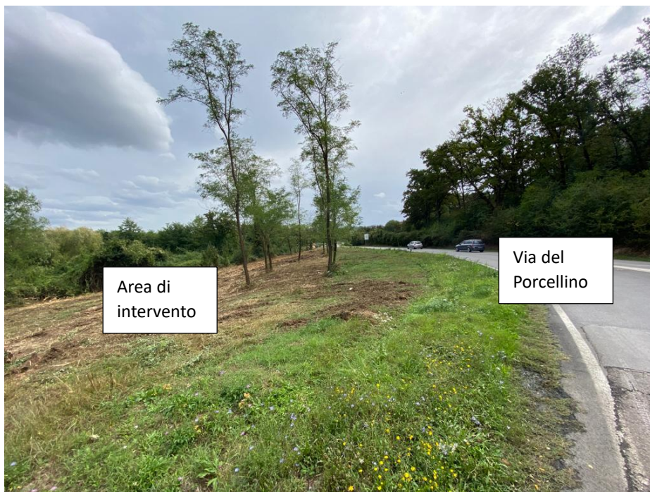
Foto 2 - Vista dall'incrocio con la SR 69 in direzione della frazione Porcellino
