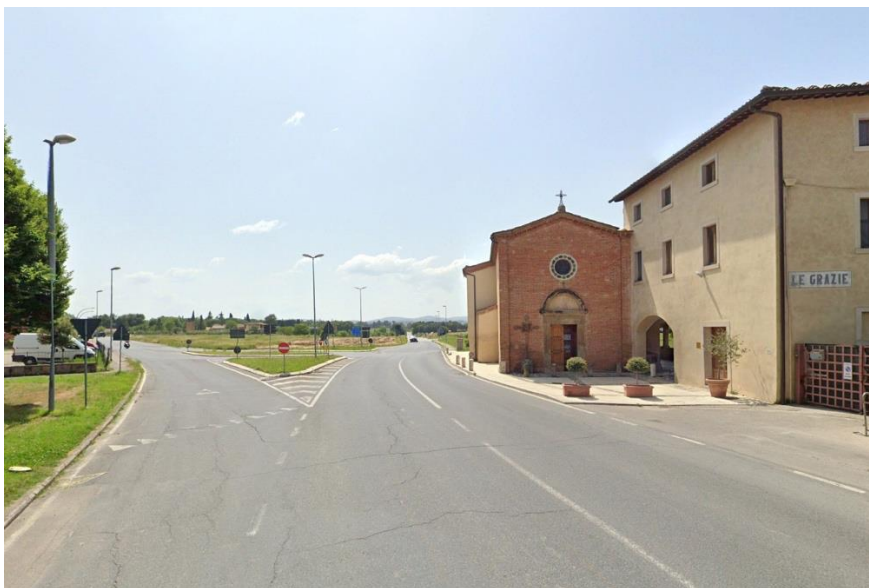
Fig. 0-vii – Mancanza di attraversamento pedonale protetto per la parrocchia di Santa Maria delle grazie. Rilievo diretto META
