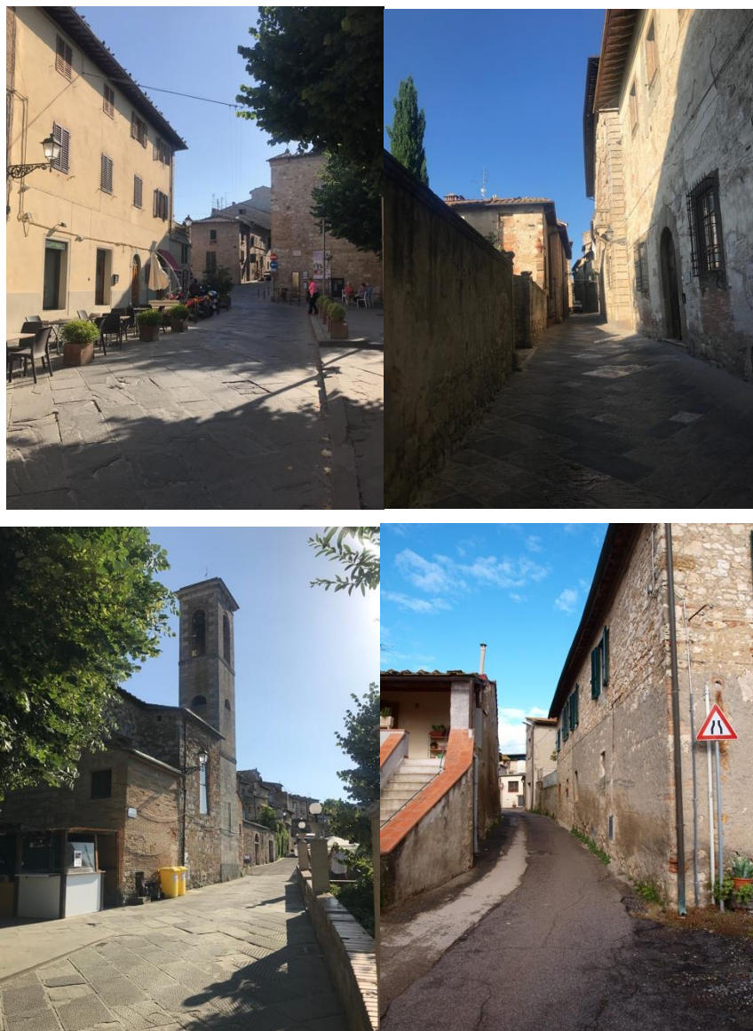
Fig. 0-iv – Mancanza di marciapiede in alcune vie del centro storico e delle frazioni
