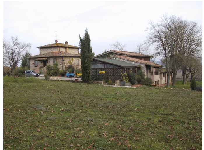
il fronte sud-est dell'edificio principale, con a sinistra la reception (in primo piano a destra)
