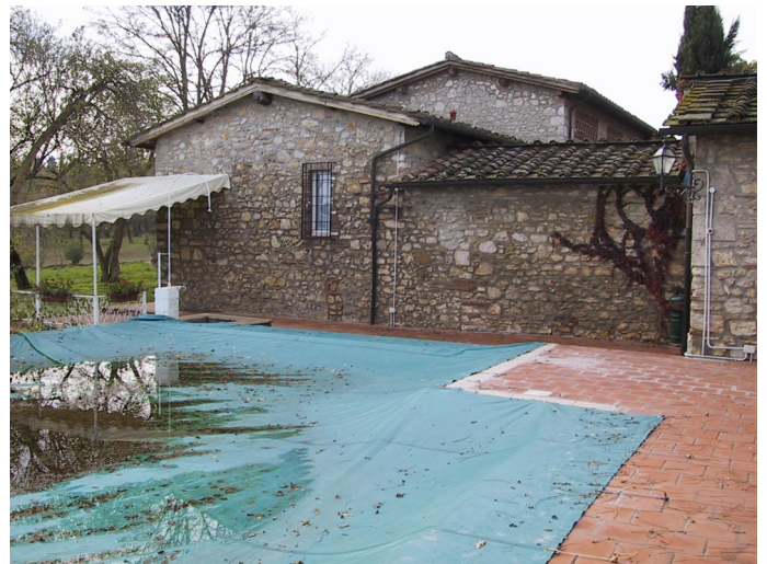
il ristorante e la piscina esistente
