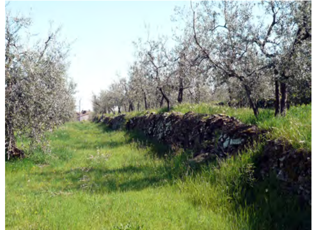
Terrazzi olivetati contenuti da muri in pietra. Relazione tra impianti agricoli e morfologia.
