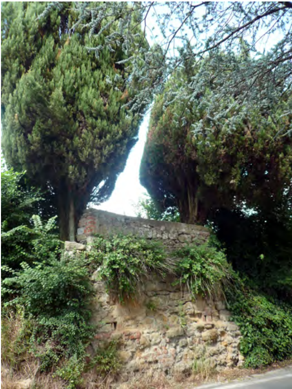
Affaccio del giardino di una villa sulla strada. Relazione tra vegetazione antropica, complesso architettonico, morfologia.
