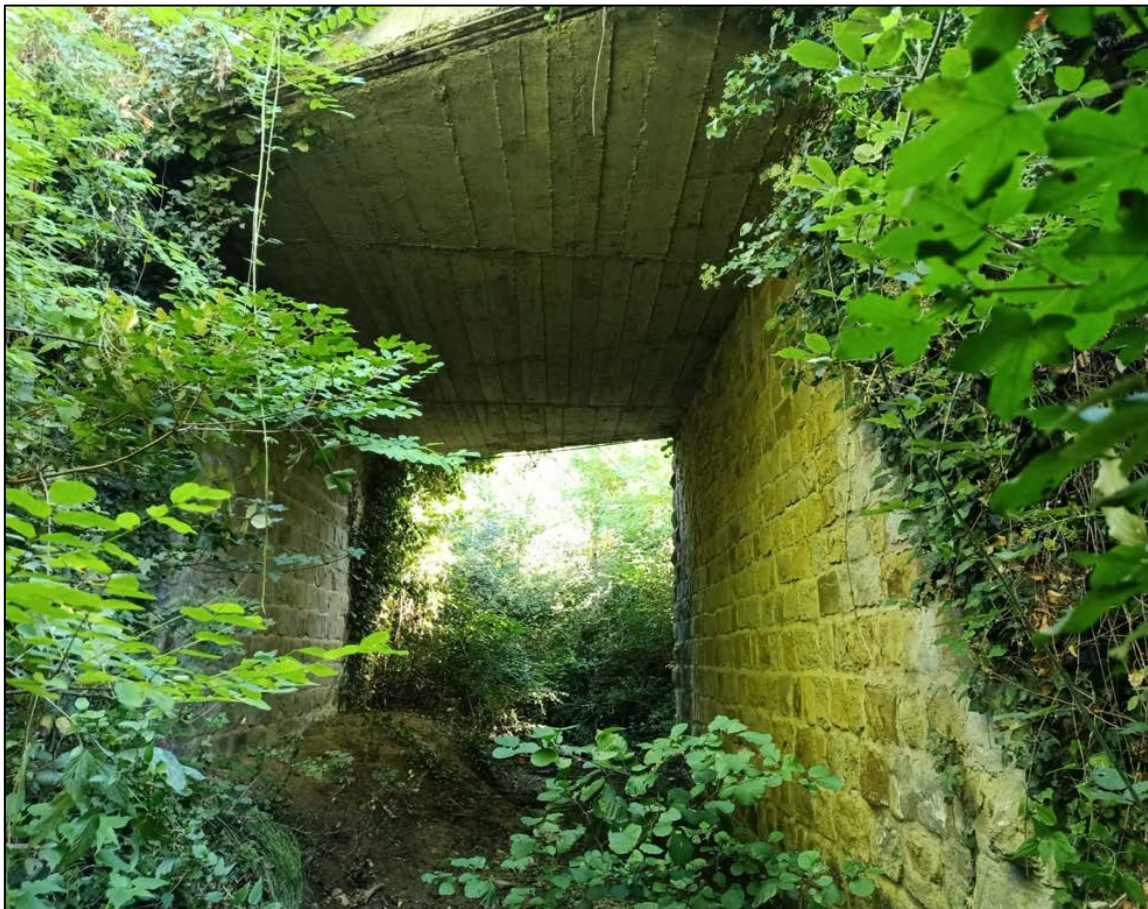
Figura 3-12 – Fosso della Vialla (foto 10)
