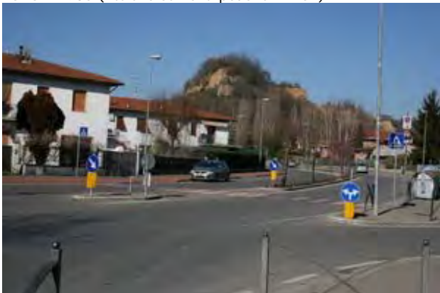
FOTO n° 936 (Attraversamenti pedonali ID 52)
