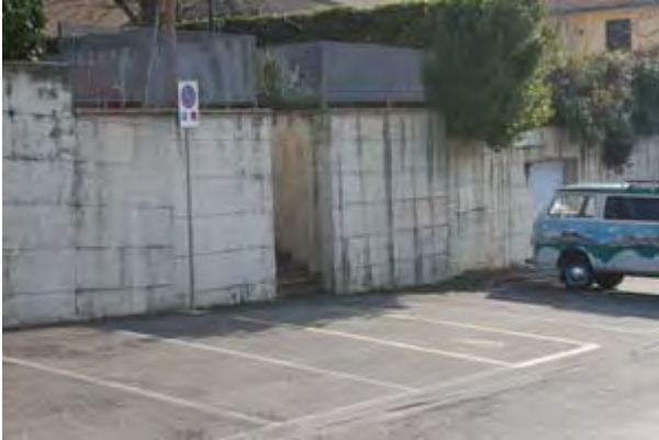
FOTO n° 752 (Parcheggi riservati ID 30)
