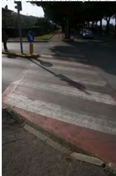
FOTO n° 755 (Attraversamenti pedonali ID 26)
