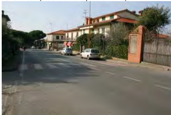
FOTO n° 505 (Attraversamenti pedonali ID 13)
