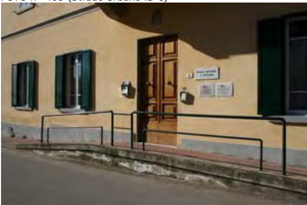
FOTO n° 405 (Strade Urbane ID 6)
