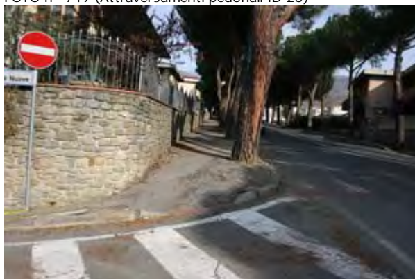
FOTO n° 749 (Attraversamenti pedonali ID 25)
