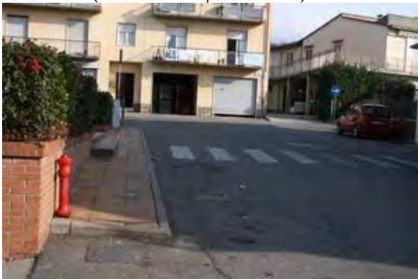
FOTO n° 471 (Attraversamenti pedonali ID 10)
