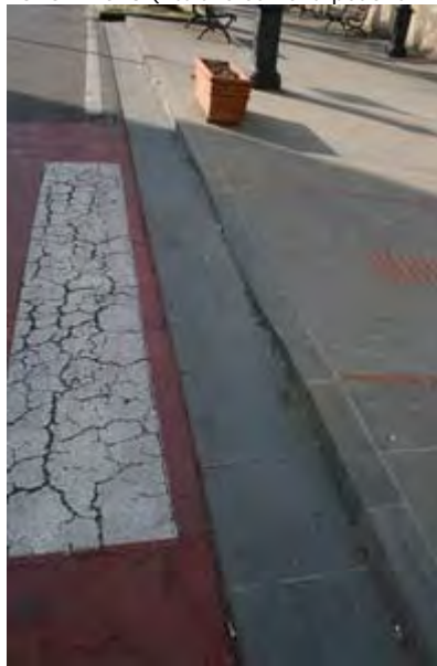
FOTO n° 513 (Attraversamenti pedonali ID 16)
