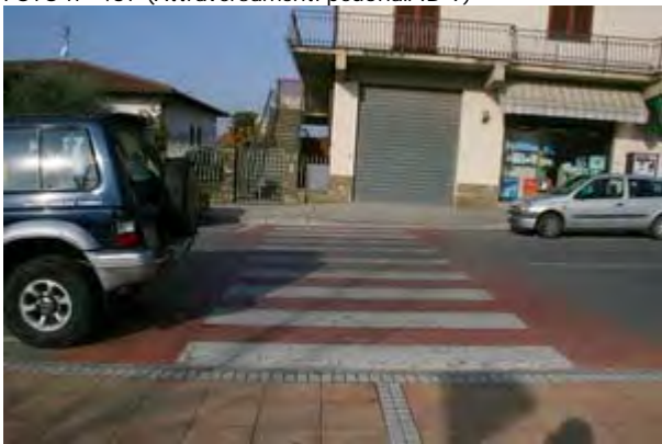
FOTO n° 467 (Attraversamenti pedonali ID 9)
