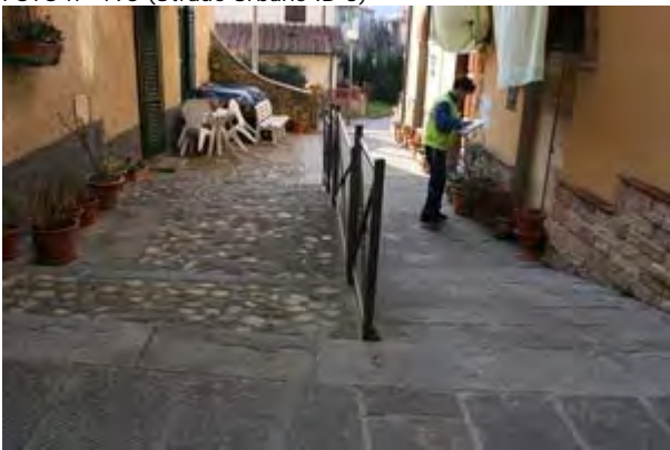
FOTO n° 196 (Strade Urbane ID 3)
