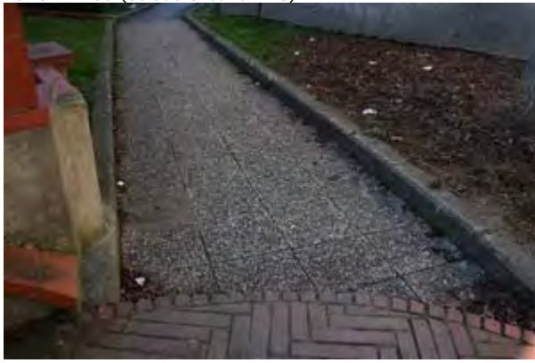
FOTO n° 165 (Strade Urbane ID 3)
