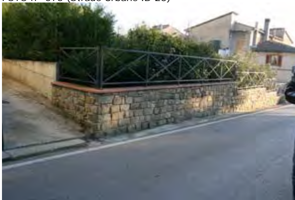
FOTO n° 576 (Strade Urbane ID 26)
