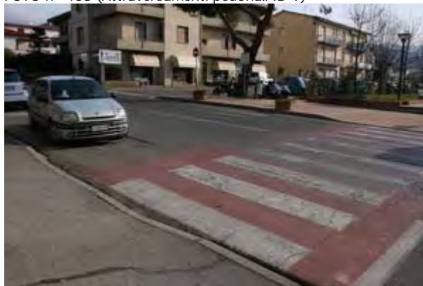
FOTO n° 468 (Attraversamenti pedonali ID 9)
