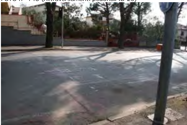
FOTO n° 748 (Attraversamenti pedonali ID 25)
