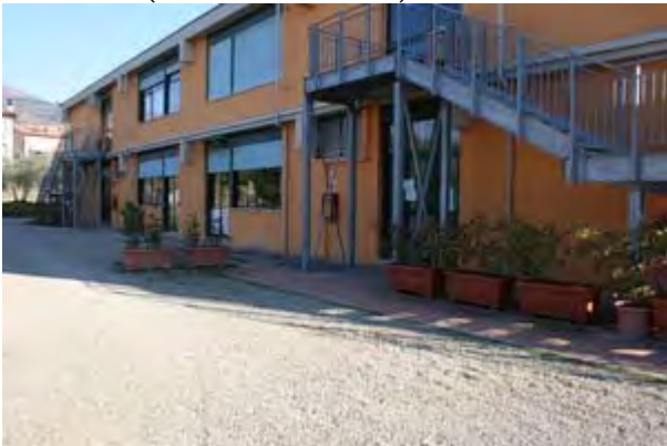
FOTO n° 336 (Edifici con resede ID 19)
