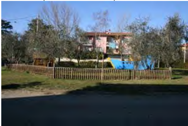
FOTO n° 337 (Edifici con resede ID 19)
