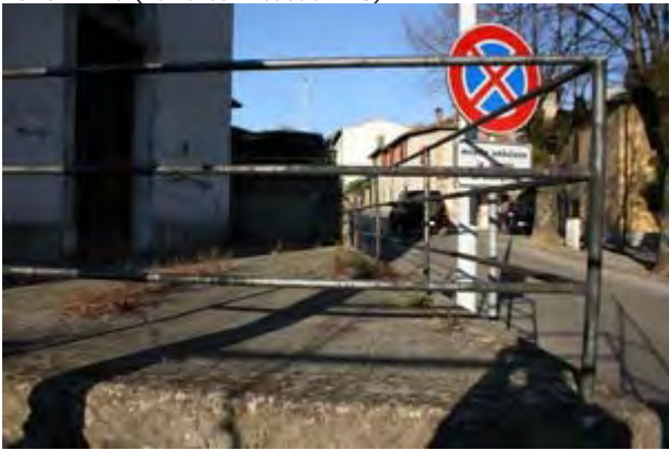
FOTO n° 16 (Edifici con resede ID 8)
