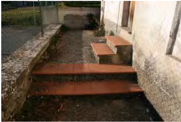
FOTO n° 17 (Edifici con resede ID 8)
