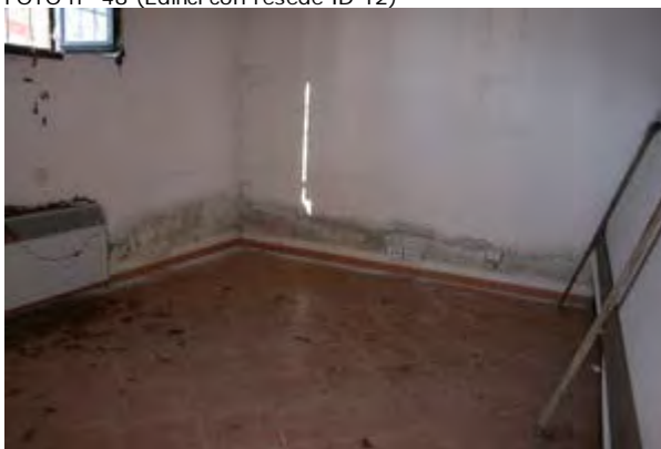
FOTO n° 48 (Edifici con resede ID 12)
