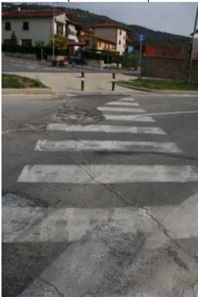
FOTO n° 442 (Attraversamenti pedonali ID 22)
