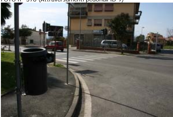
FOTO n° 376 (Attraversamenti pedonali ID 9)
