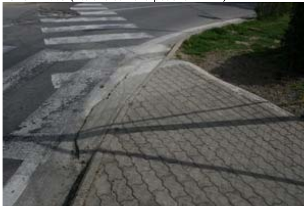
FOTO n° 443 (Attraversamenti pedonali ID 22)
