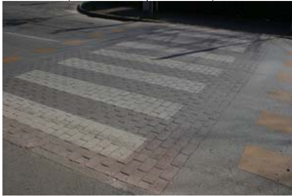
FOTO n° 429 (Attraversamenti pedonali ID 20)
