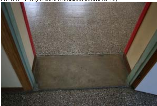
FOTO n° 143 (Percorsi e ambienti interni ID 12)
