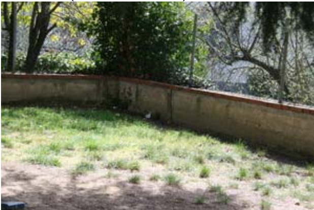
FOTO n° 207 (Edifici con resede ID 5)
