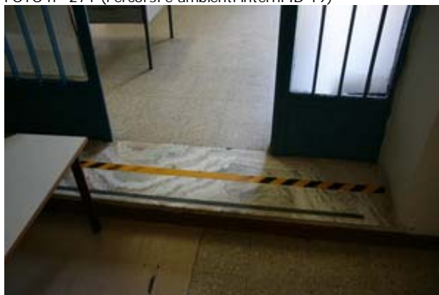
FOTO n° 271 (Percorsi e ambienti interni ID 19)
