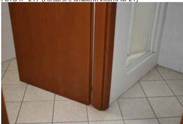
FOTO n° 297 (Percorsi e ambienti interni ID 21)
