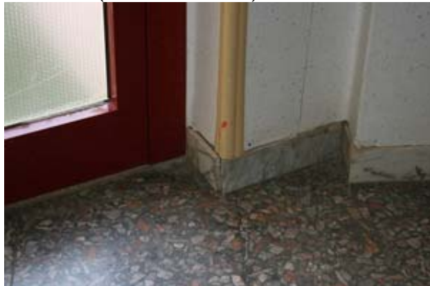
FOTO n° 209 (Edifici con resede ID 5)
