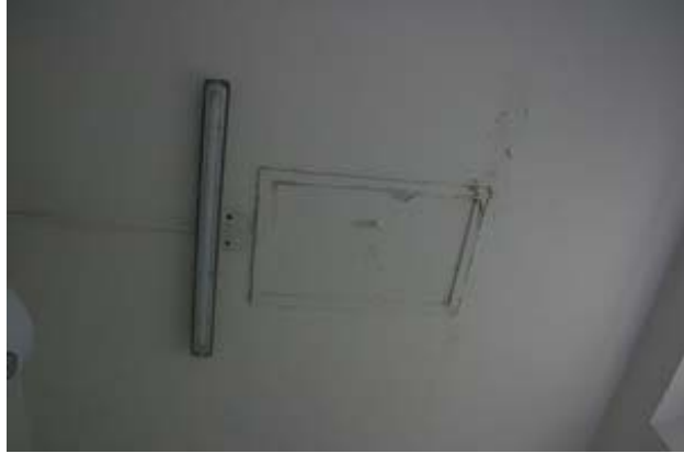
FOTO n° 148 (Percorsi e ambienti interni ID 12)
