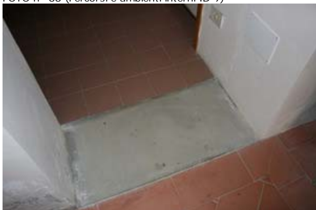
FOTO n° 88 (Percorsi e ambienti interni ID 9)
