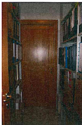
Punti e aspetti critici da sistemare negli edifici pubblici
