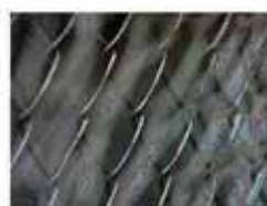
Utilizzo di rete zincate non verniciate a maglia sciolta da impiegarsi a protezione e sicurezza delle aree pertinenziali degli edifici mitigate con l'impianto addossato di specie arbustive autoctone in siepi
