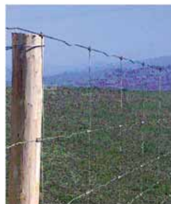
Utilizzo di rete zootecnica a maglia sciolta su pali sbucciati di castagno da impiegarsi nel territorio aperto
