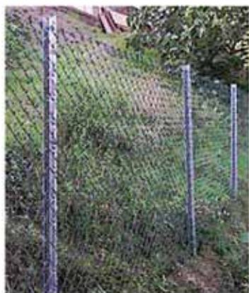
Utilizzo di pali in cemento o metallo non verniciati
