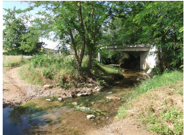
Foto 8 Ponte borro Fornace (vista verso valle).
