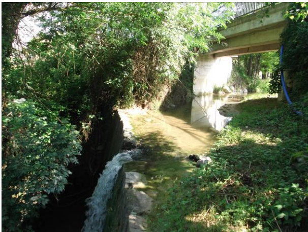
Foto 9 Borro Steccata vista a valle del ponte (vista verso monte).
