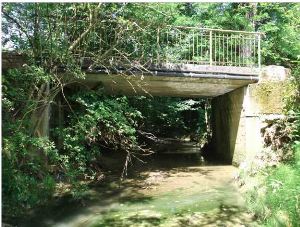
Foto 15 Borro Spina vista ponte 06 (vista verso monte).
