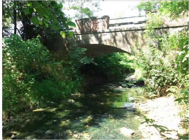
Foto 14 Borro Spina vista ponte 05 (vista verso monte).
