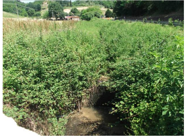
Foto 2 Molinaccio tratto a monte del ponte 03 (vista verso monte).
