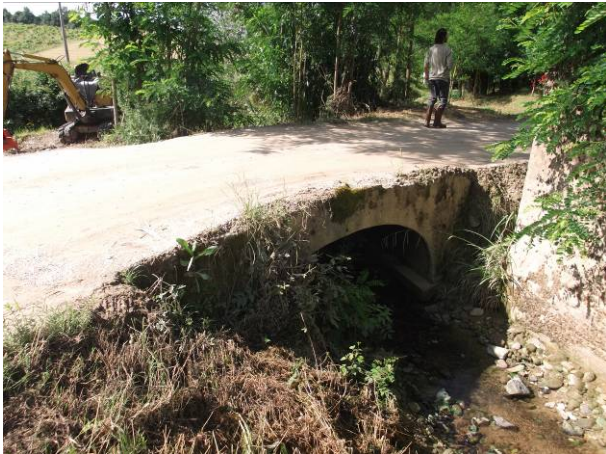
Foto 7 Ponte borro Steccata (vista verso valle).
