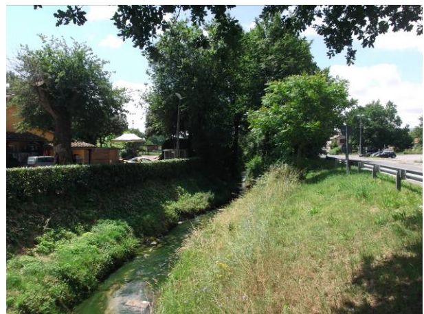
Foto 12 Borro Spina vista a valle del ponte 03 (vista verso valle).
