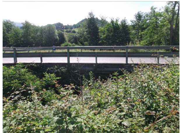
Foto 10 Borro molinaccio ponte SP (vista verso valle).
