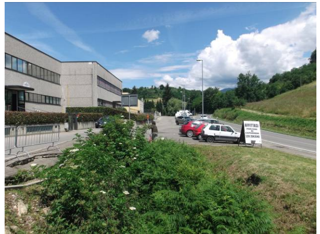
Foto 4 Molinaccio cista uscita ponte 04 (vista verso monte).
