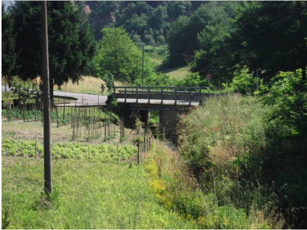
Foto 1 Ponte Molinaccio 01 (vista da valle verso monte).
