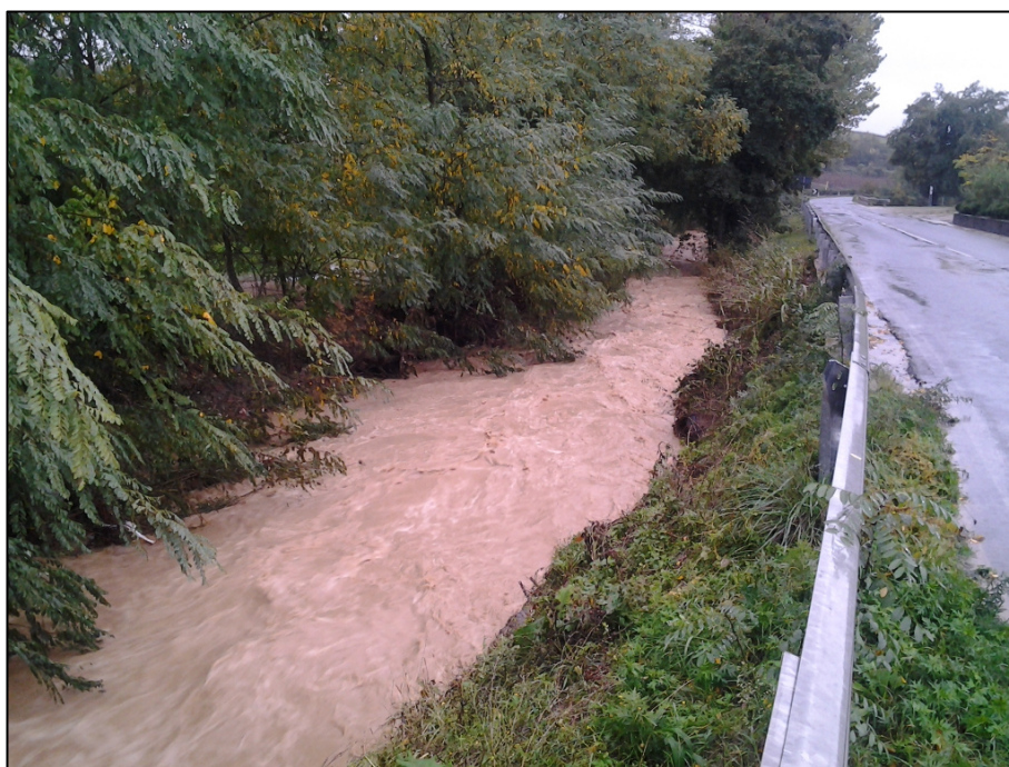
Foto 1.4 Borro della Spina nella curva della SP Botriolo a monte di Campo Cellani - vista verso valle (fonte: www.valdarnopost.it ).
