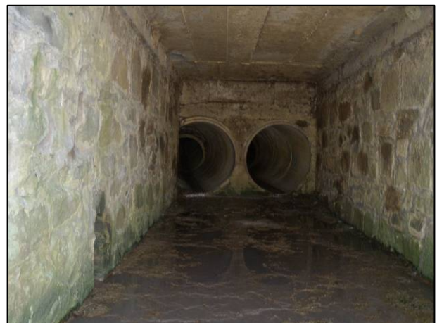
Foto 2.8 Fosso Campo Cellani tombino sotto SP Botriolo particolare tubazioni CLS DN 800 e DN 600 (vista verso monte).
