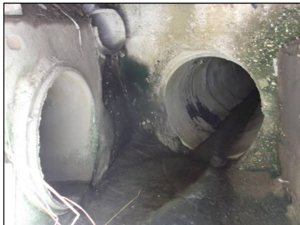
Foto 3.10 Lottizzazione industriale Botriolo. Fognatura meteorica CLS DN 800 a monte della SP Botriolo.
