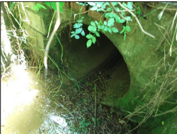
Foto 3.5 Fosso Zona ind. Botriolo vista ingresso in rete fognaria CLD DN800.
