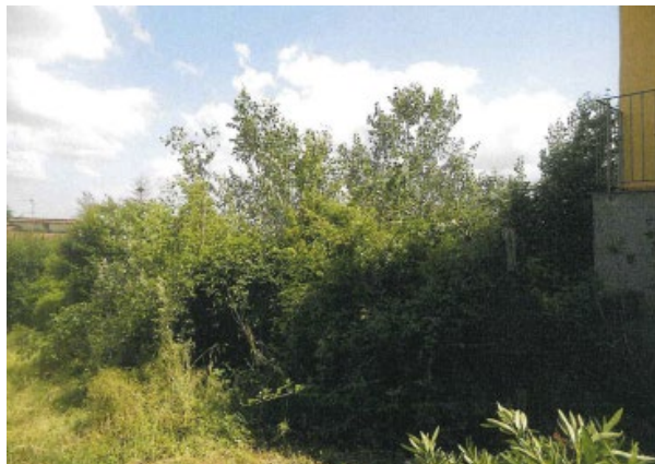
vista dell'area con opere non completate (ID3.01)
