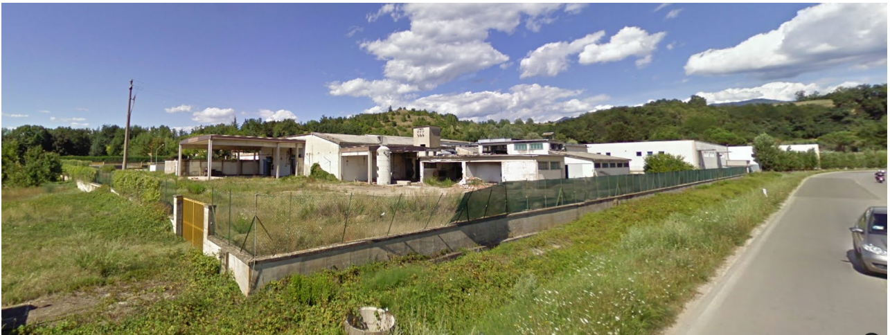
vista al 2011, prima della demolizione e ricostruzione (da Google Streetview)
