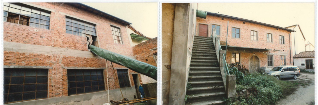
IC3.07: i fabbricati oggetto di sostituzione, all'interno dell'area di intervento (dalla schedatura del R.U.)
