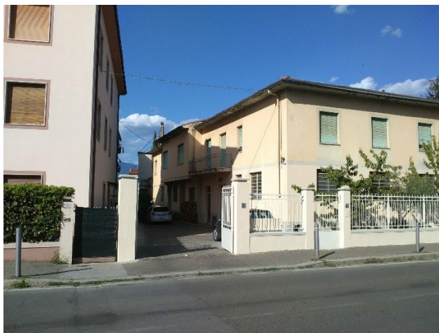
viste dell'edificio da recuperare, lungo via della Resistenza
