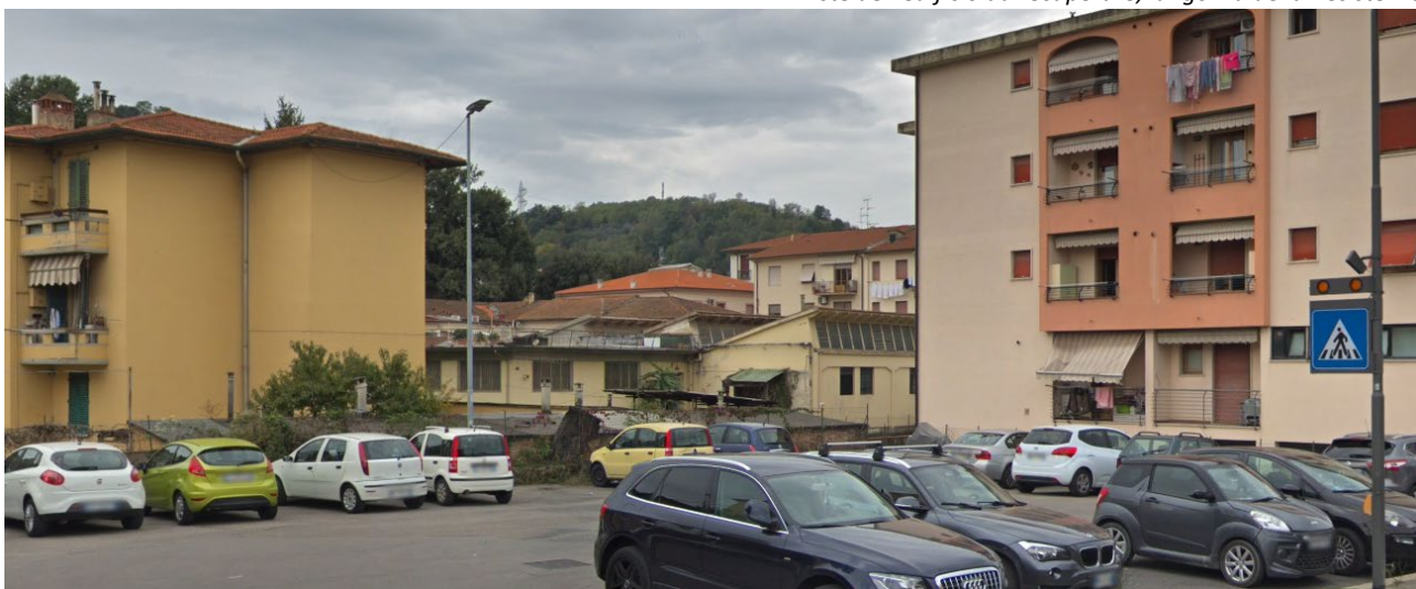
vista dell'edificio produttivo, interno dell'isolato, da via Petrarca (da Google Streetview)
