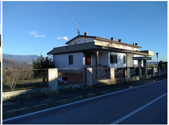
edifici adiacenti all'area di intervento su via Rosai
