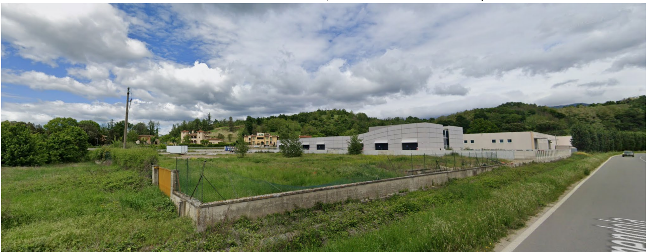
vista attuale del lotto residuo, in primo piano, e degli edifici già realizzati (da Google Streetview)
