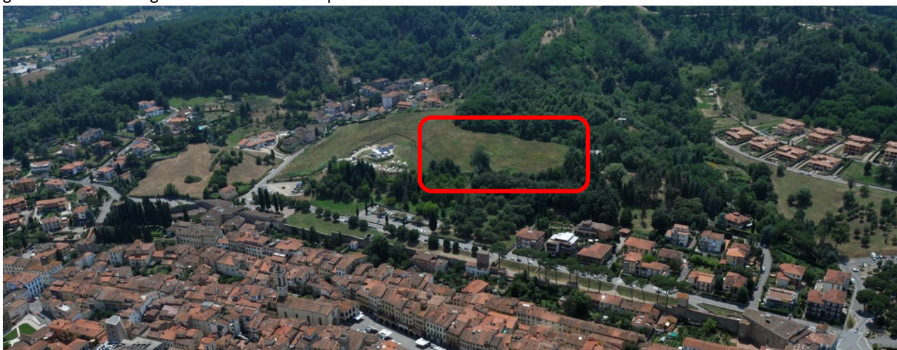
vista del complesso, a monte del centro antico, con evidenziata l'area per i nuovi impianti sportivi
