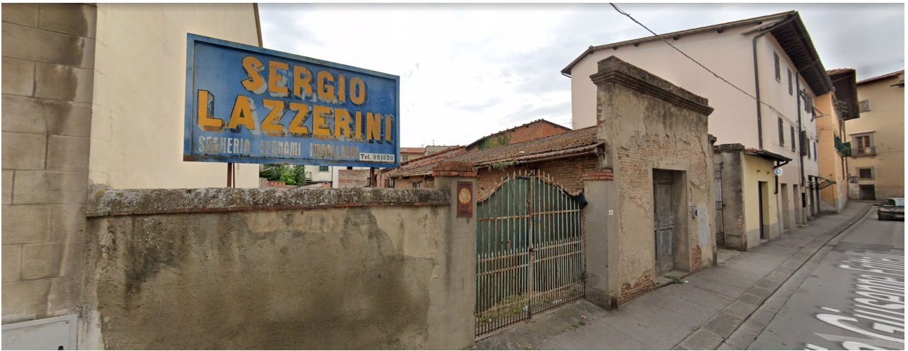
IC3.06: il fronte su via Frittelli (da Google Streetview)
