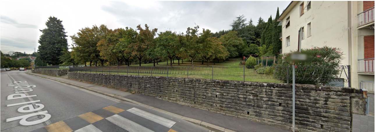
l'area di ampliamento (da Google Streetview)
