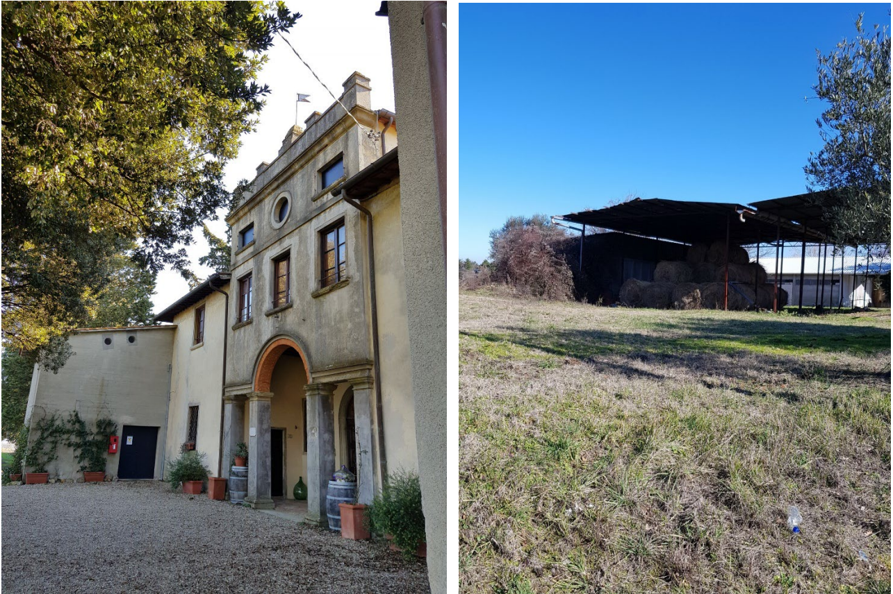
Villa l'Entrata e i manufatti oggetto di demolizione nel Piano di Recupero
