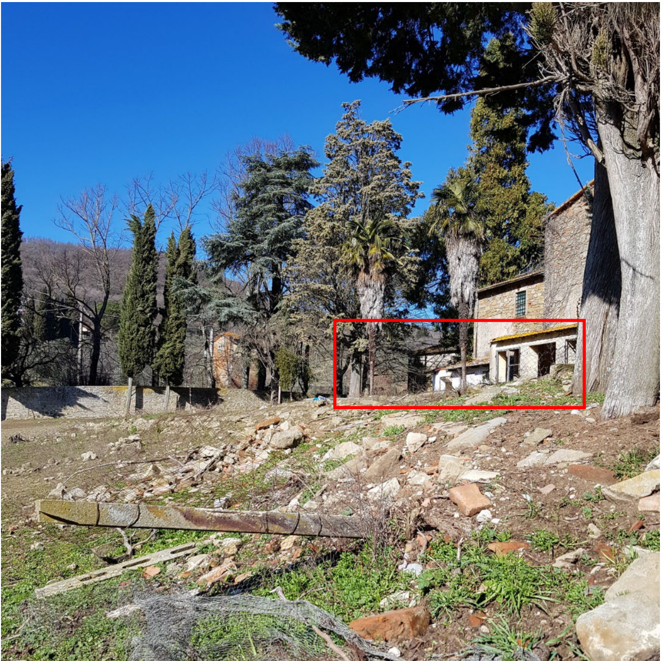
vista del fronte sud e dell'area all'interno del muro di recinzione con indicazione della posizione dei volumi interrati/seminterrati
