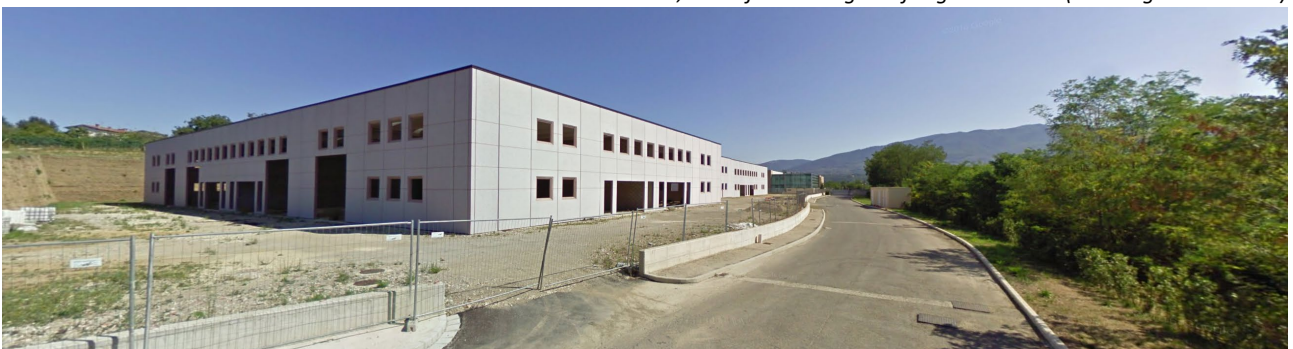
vista della parte a monte, già ultimata (da Google Streetview)
