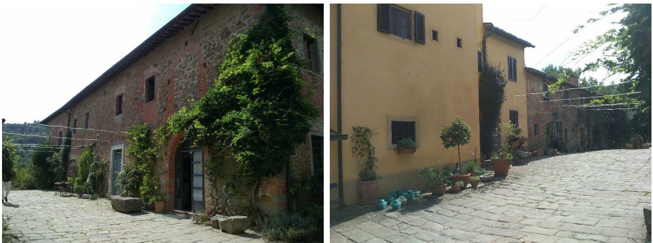
i fronti prospettanti lo spazio lastricato centrale degli edifici 01 e 02
