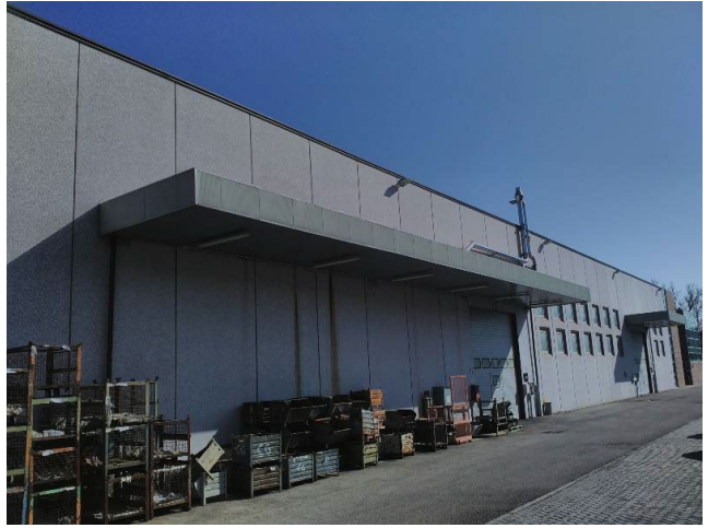
edifici realizzati nella parte a monte
