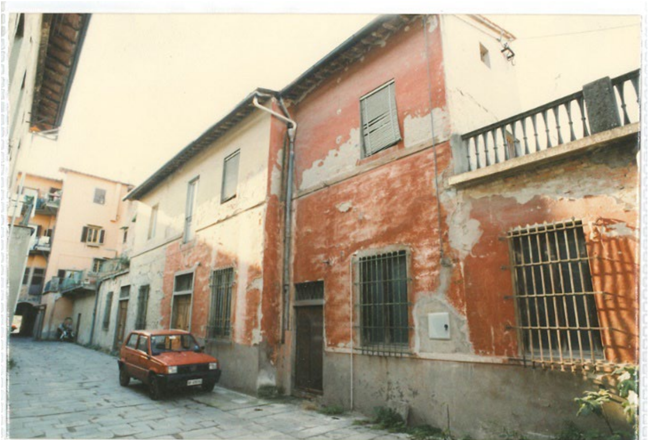
IC3.07: il fronte sul passaggio interno (dalla schedatura del R.U.)
