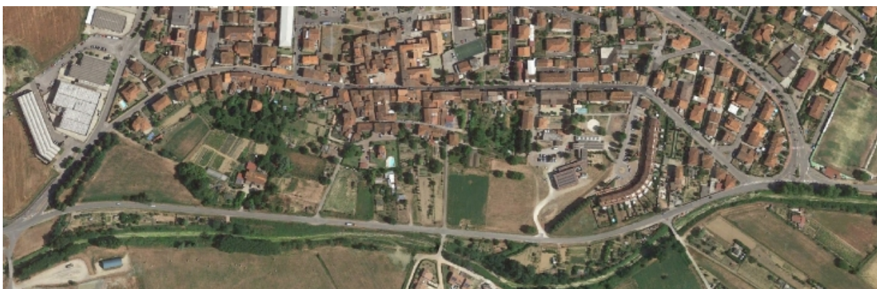
Vista aerea del tessuto storico di Faella
