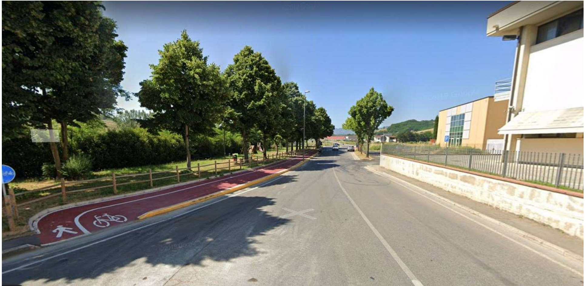
1_ZONA DELLA ROTATORIA ALL'INGRESSO SUD DI FAELLA
