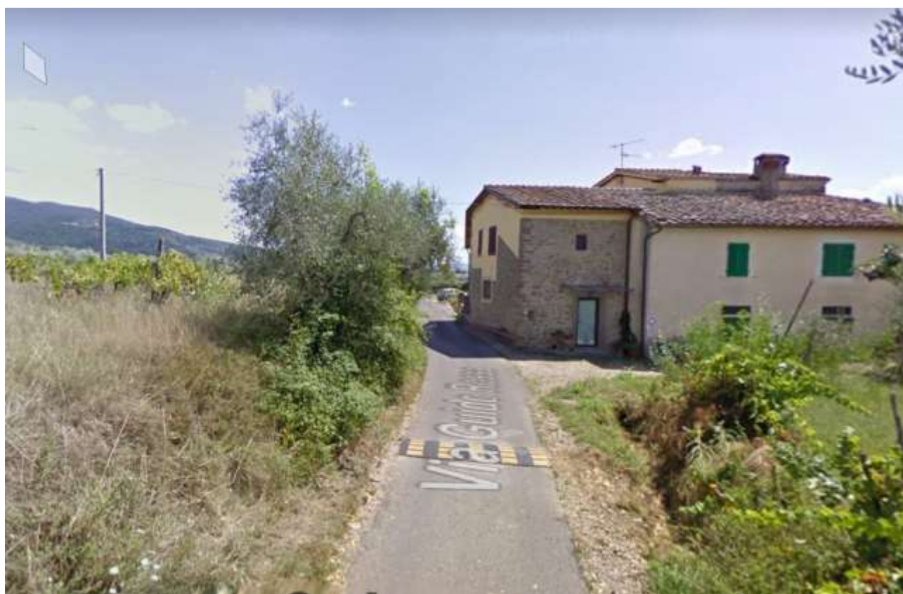
Via Monamea in prossimità del fabbricato adiacente alla sua sede stradale
