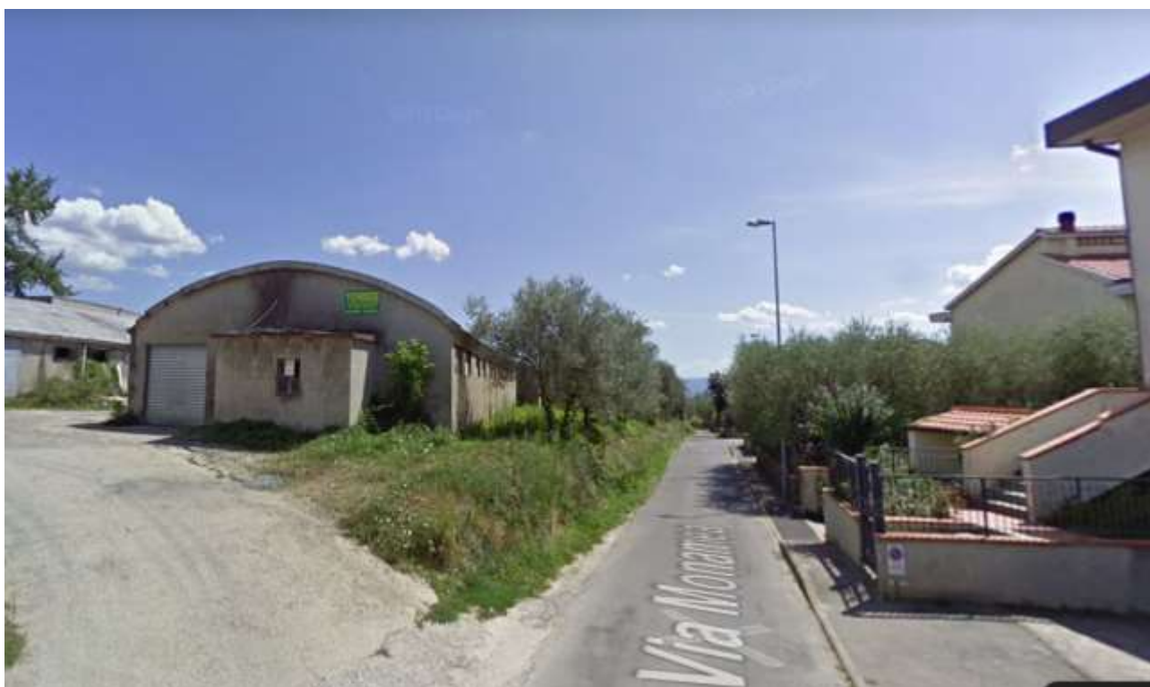
Via Monamea in prossimità dei capannoni del quale la prima porzione potrebbe necessitare di essere abbattuta
