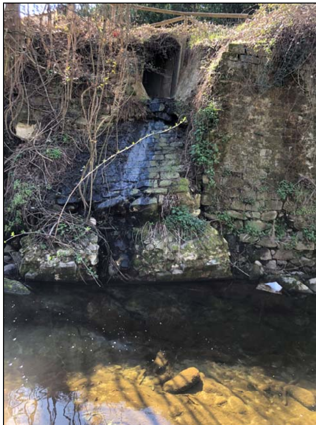
Figura 3: Vista sbocco reticolo idraulico d'intervento sul Resco Simontano.
