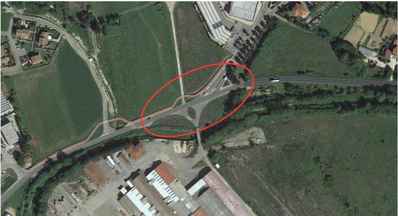
[Area di intervento]
