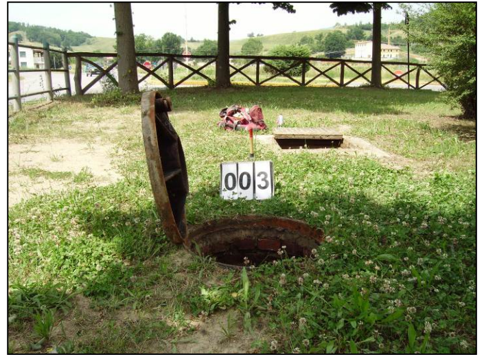
Foto 10. – Borro Barberaia pozzetto PZ_003
