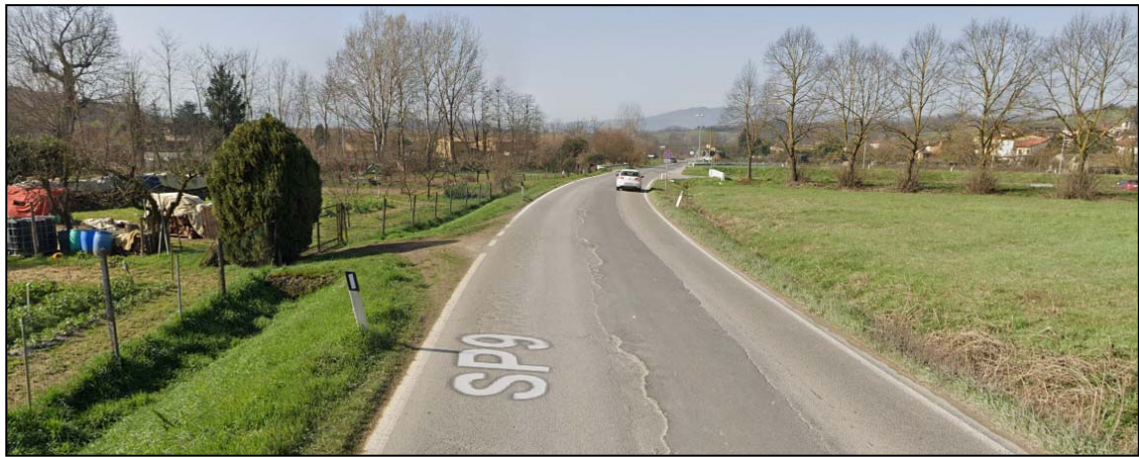
Foto 5. - Vista tratto SP9 nel tratto di inizio della pista est – vista verso valle.
