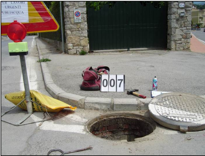
Foto 9. – Borro Barberaia pozzetto PZ_007
