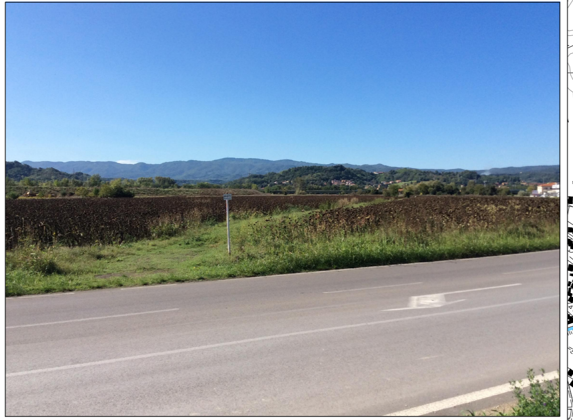
- Visuale verso la tratta adiacente la Cassa di Espansione Pizziconi
