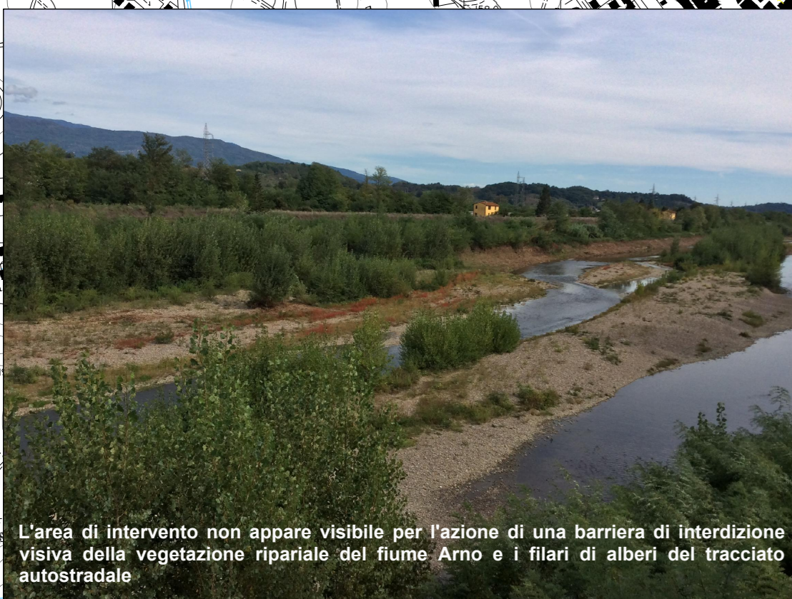
- Visuale verso l'area d'intervento dal "Ponte Del Matassino"
