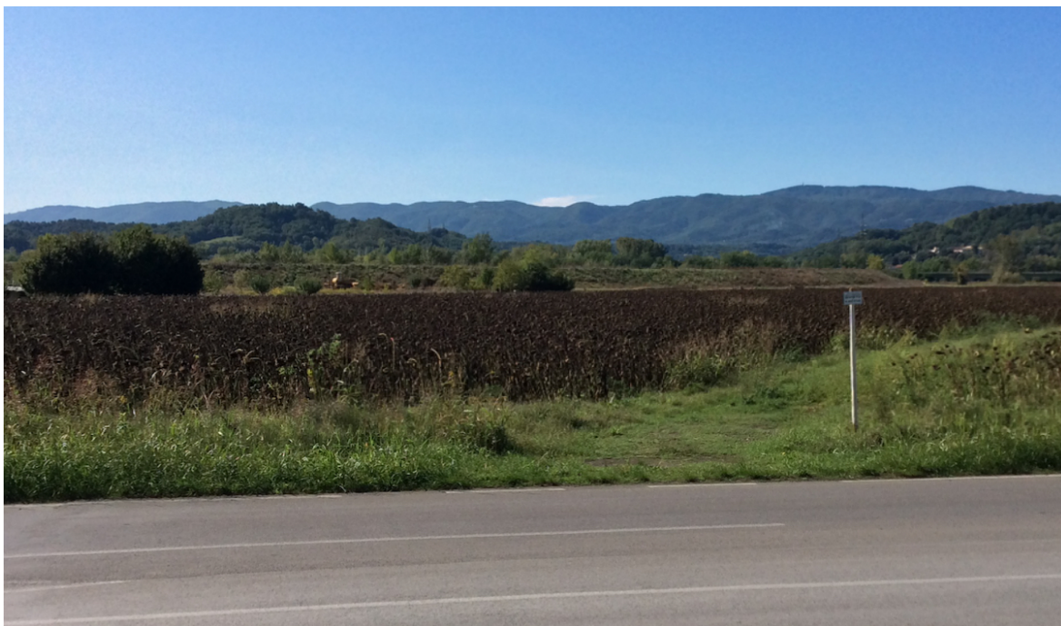
Figura 2:31 - i rilevati della cassa di espansione di Pizziconi
