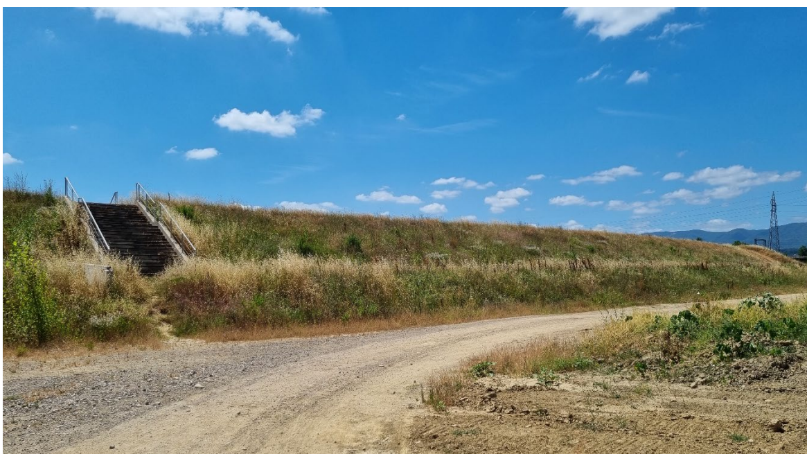
Figura 2:38 - Rilevato arginale della cassa di espansione di Pizziconi
