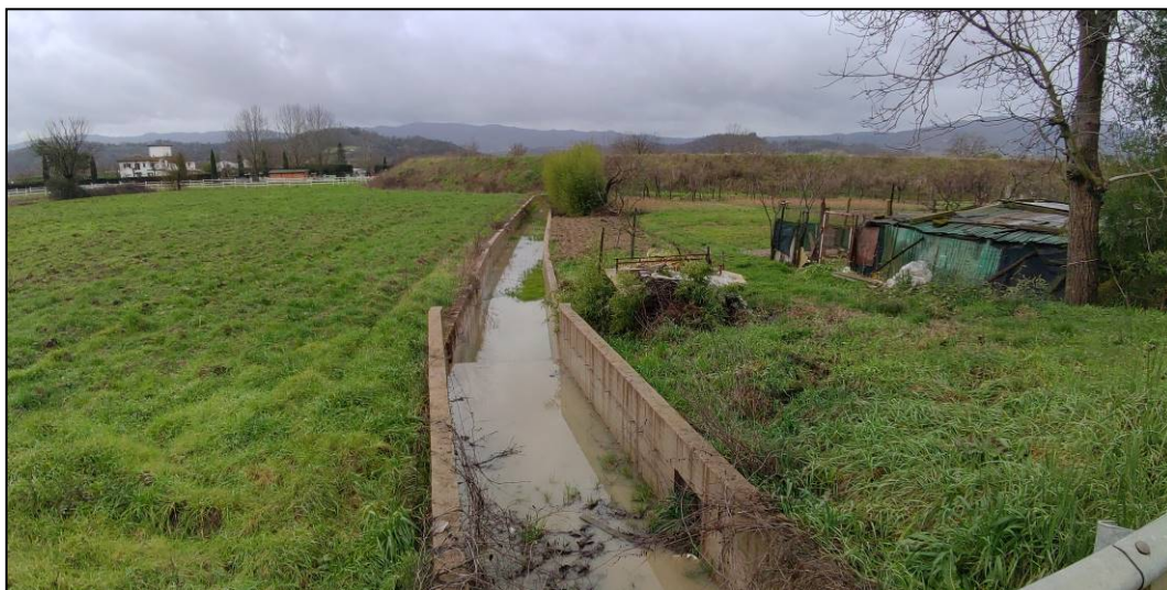
Foto 2. Canale in c.a. esistente in zona rotatoria Montalpero.
