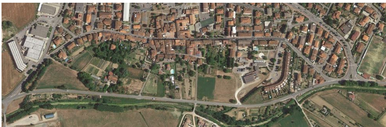
Vista aerea del tessuto storico di Faella
