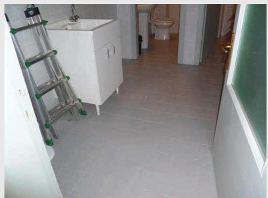
WC PIANO PRIMO
