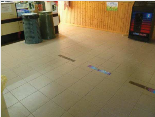
INTERNO ZONA BAR
