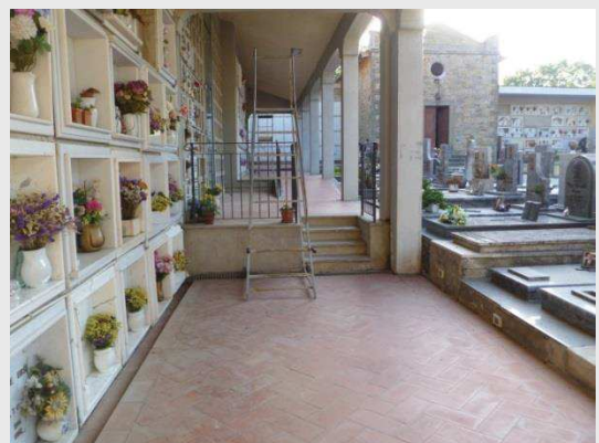
PERCORSO SOTTO LA LOGGIA
