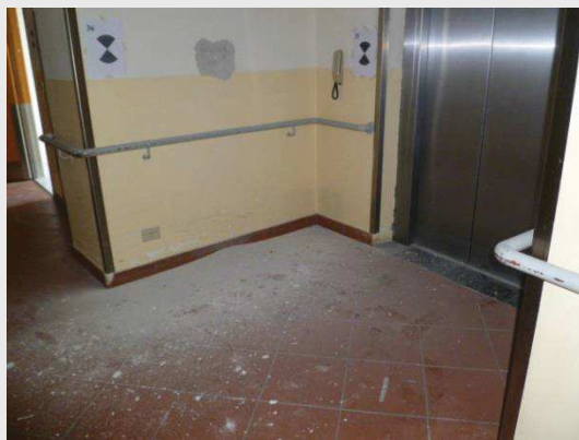
VANO ASCENSORE PIANO PRIMO
