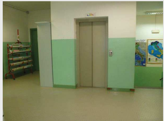
VANO SCALE E ASCENSORE
