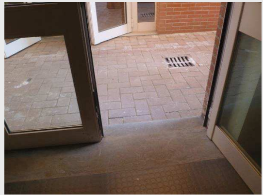
INGRESSO (VISTO DA INTERNO PALESTRA)
