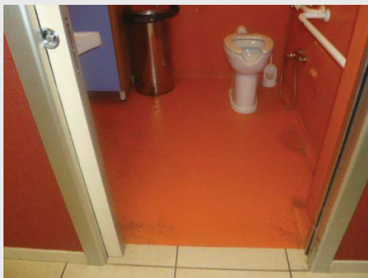
SERVIZIO IGIENICO PIANO TERRA
