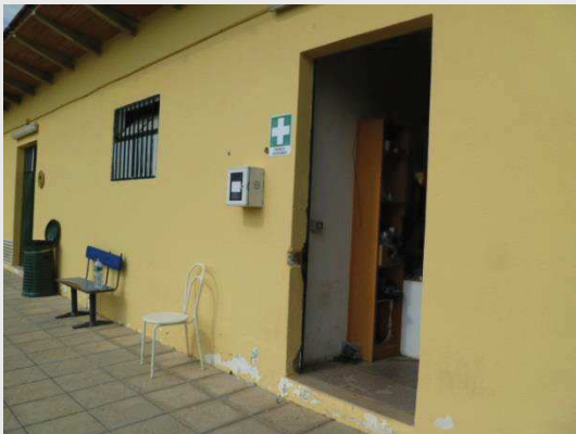
INGRESSO LOCALI INFERMERIA E WC
