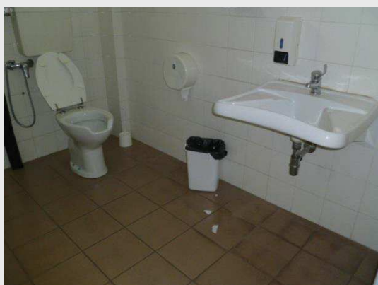
SERVIZIO IGIENICO RISERVATO
