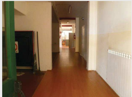
CORRIDOIO ZONA SPOGLIATOI
