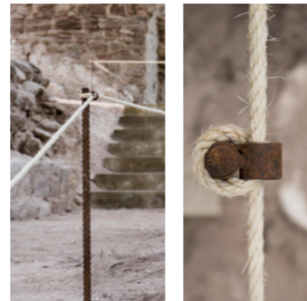
Parapetto percorsi esterni
